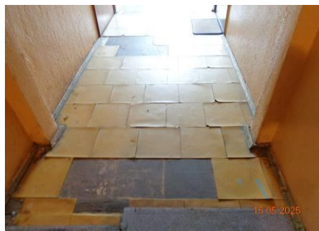
Bojāts linoleja grīdas klājums koplietošanas gaitenī 3.stāvā
