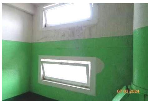
Logi kāpņu telpā
