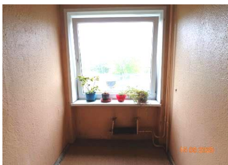
PVC logs 3.stāva koplietošanas gaitenī galā
