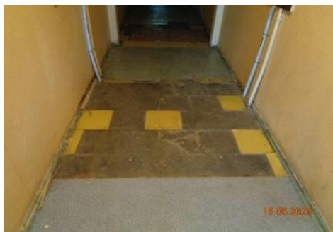
Bojāts linoleja grīdas klājums koplietošanas gaitenī 3.stāvā
