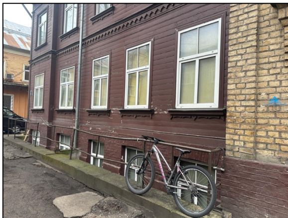
Attēls Nr. 7: Skats uz vērtējamā objekta logiem
