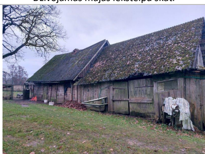
Kūts ēkas (kadastra apz. 9615 006 1301 003) un šķūņa ēkas (kadastra apz. 9615 006 1301 004) fasādes skati
