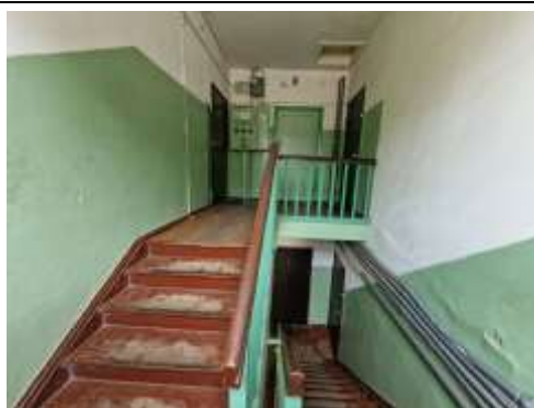
2.stāva kāpņu telpa
