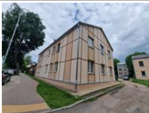
Dzīvojamā māja V.Seiles ielā 28
