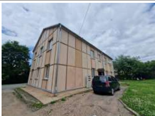
Dzīvojamā māja V.Seiles ielā 28
