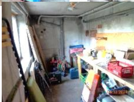
Katlu un tehniskā telpa pagrabstāvā
