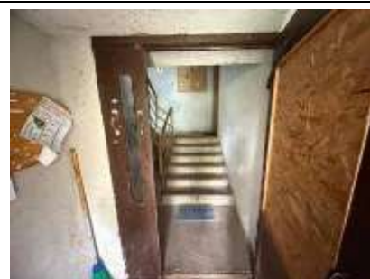
1 stāva kāpņu telpa
