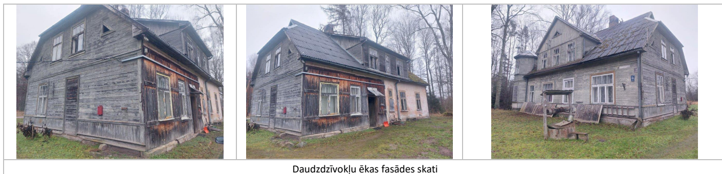
Daudzdzīvokļu ēkas fasādes skati
