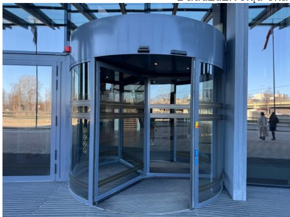
Daudzdzīvokļu ēkas ārdurvis
