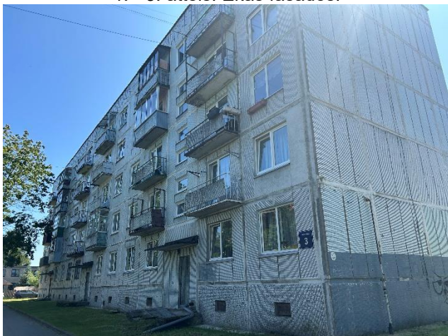
1. - 3. attēls. Ēkas fasādes.
