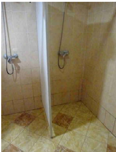
Sauna (telpa Nr. 8 – izveidotas dušas)
