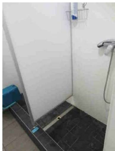
Iekštelpa (telpa Nr. 18 – izveidotas dušas)
