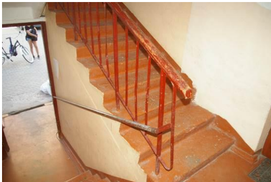
Dzīvojamā ēka ar kadastra apzīmējumu 1700 036 0141 001, koplietošanas telpa
