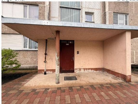
Daudzdzīvokļu ēkas ārdurvis
