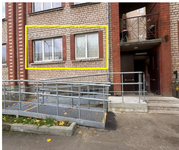
Ieeja kāpņu telpā ar dzīvokļa novietojumu
