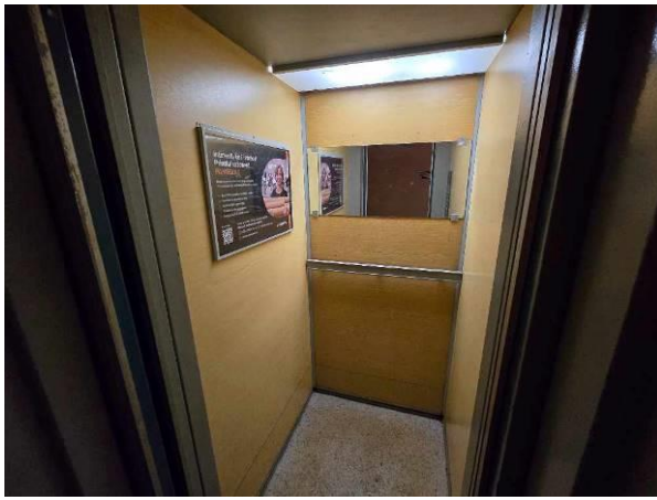
Kāpņu telpas lifts
