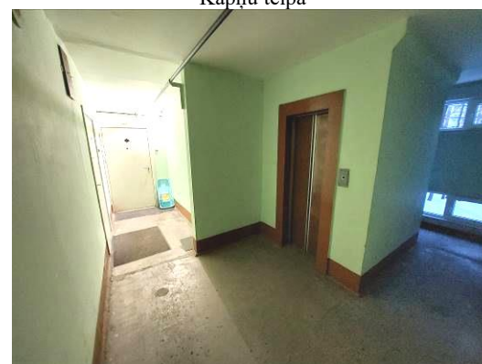
Kāpņu telpa, lifts
