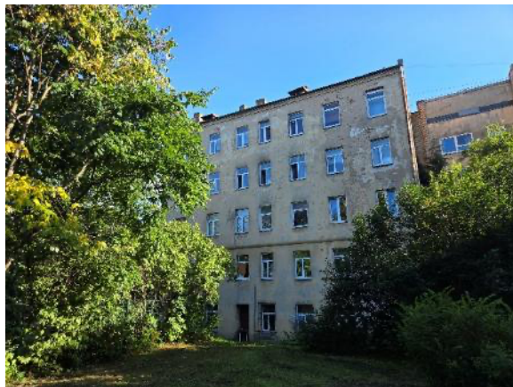
Daudzdzīvokļu ēka Latgales iela 153A
