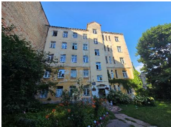
Daudzdzīvokļu ēka Latgales iela 153A
