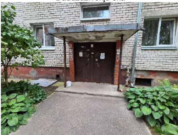
Daudzdzīvokļu ēkas ārdurvis
