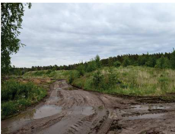
Zemesgabalā izveidotie pagaidu zemes ceļi
