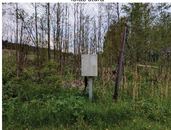
Skats uz elektrības pieslēguma vietu pie zemesgabala
