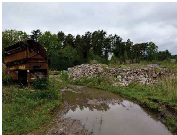
Skats uz zemes ceļu caur zemesgabalu un tajā esošajiem būvgružiem
