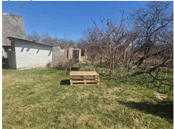
Šķūnis (kad.apz.6201 024 0067 002) – daļēji demontēts
