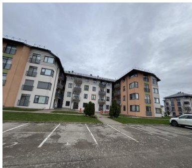
Lietošanā esošā autostāvvietā.
