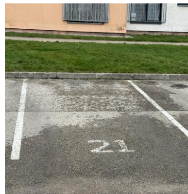
Lietošanā esošā autostāvvietā.
