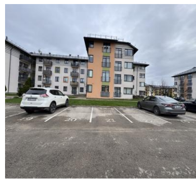
Lietošanā esošā autostāvvietā.
