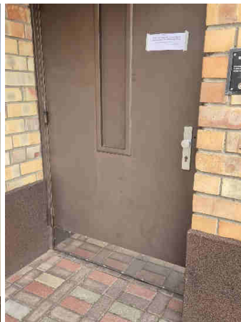
Kāpņu telpas ārdurvis
