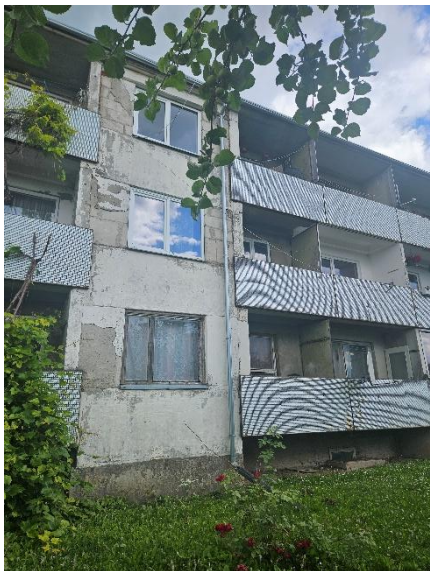
Ēkas fasāde ar dzīvokļa logiem
