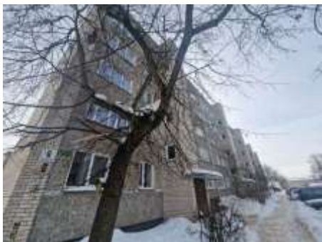
Dzīvojamā māja Bauskas ielā 6
