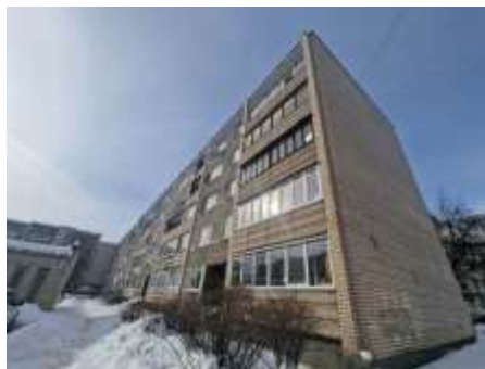
Dzīvojamā māja Bauskas ielā 6
