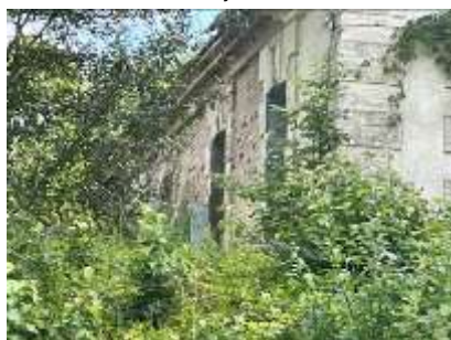
Nedzīvojama ēka, elektrības skapis
