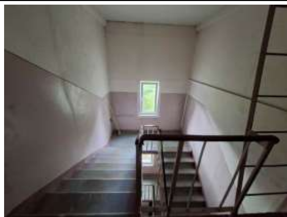
3.stāva kāpņu telpa
