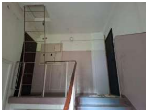
3.stāva kāpņu telpa
