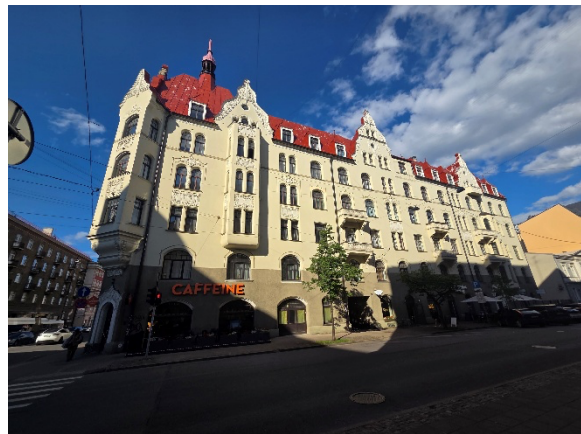
Daudzdzīvokļu ēka no Stabu ielas
