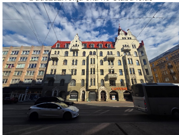
Daudzdzīvokļu ēka no Brīvības ielas
