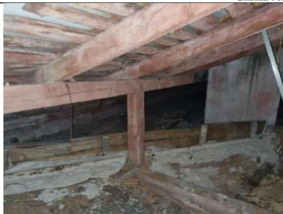
4.8.1.2. att. Jumta nesošās konstrukcijas
