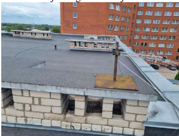
4.8.2.5. att. Padomju laika korpusa jumta segums
