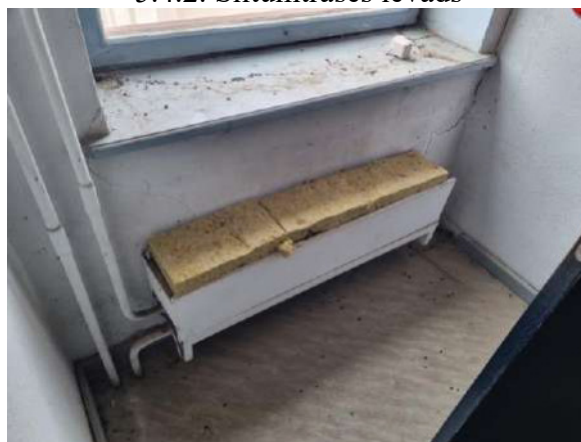
5.4.4. att. Radiatori nosegti ar akmens vates siltumizolāciju
