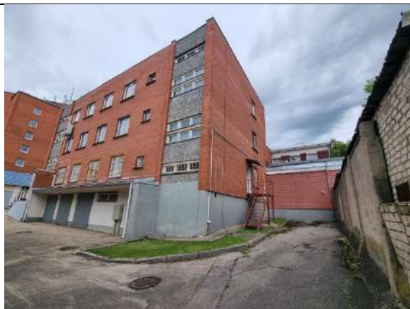
3.1.1. att. Asfaltbetona segums, lokāli seguma bojājumi
