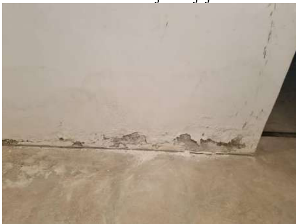
4.5.1.1. att. Mitruma ietekmē radīti pagrabstāva mūra sienas apdares bojājumi
