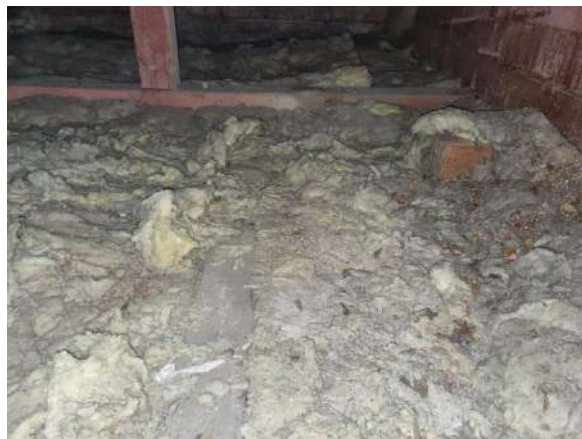
4.6.2.2. att. Koka siju bēniņu pārsegums
