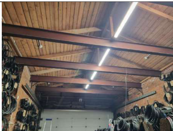
4.8.1.1. att. Jumta nesošās konstrukcijas garāžā
