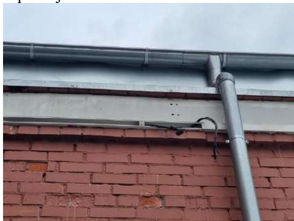
5.9.1. att. Nedemontēts elektroapgādes kabelis
