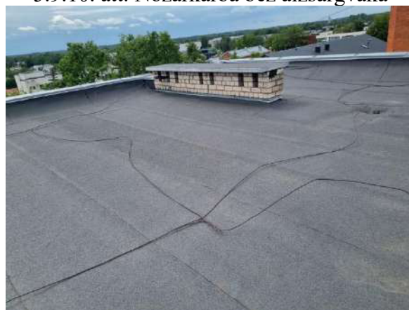
5.9.12. att. Zibensaizsardzība nav darba kārtībā
