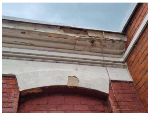
4.2.5.2. att. Ķieģeļu velvju pārsedze, nevienmērīgas sēšanās plaisa
