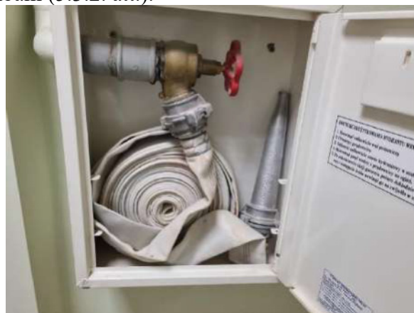
5.3.2. att. Ugunsdzēsības ūdensvads. Šļūtenei pievienotais stobrs nav noslēdzams
