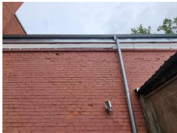
5.9.2. att. Nedemontēts elektroapgādes kabelis un gaismeklis
