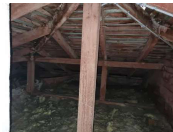
4.8.1.4. att. Jumta nesošās konstrukcijas
