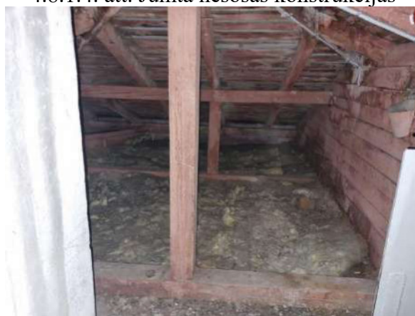
4.8.1.6. att. Jumta nesošās konstrukcijas
