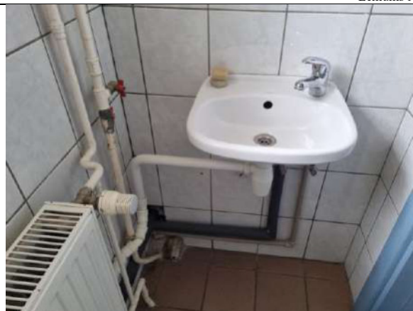
5.1.2.4. att. Plastmasas kanalizācijas caurules
