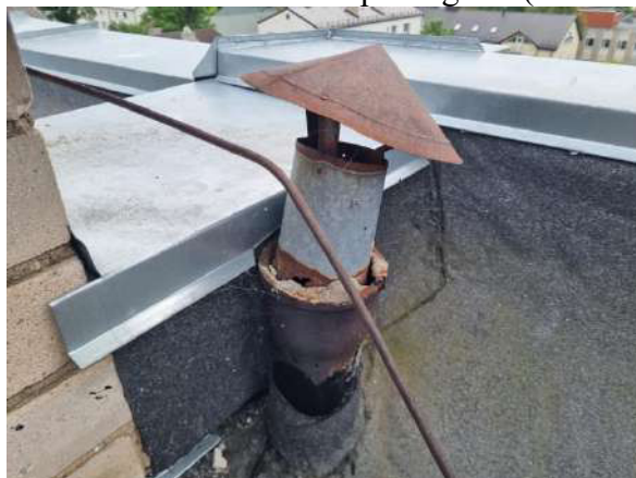
5.1.2.1. att. Nav veikta kanalizācijas vēdināšanas jumtiņa nomaina
