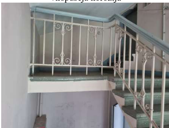
4.10.7. att. Ārējās evakuācijas kāpnes, virspusēja korozija
