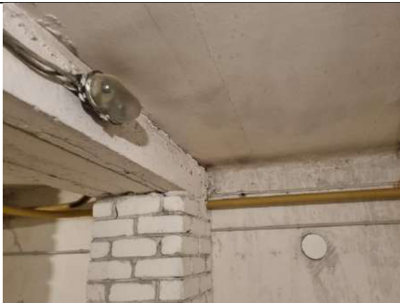
4.6.1.1. att. Pagrabstāva pārsegums veidots no dobajām plātnēm
