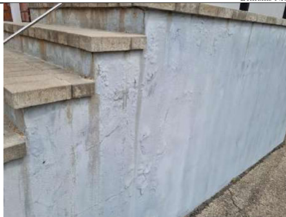
4.10.4. att. Ārējās kāpnes, mitruma ietekmē bojāta apdare
