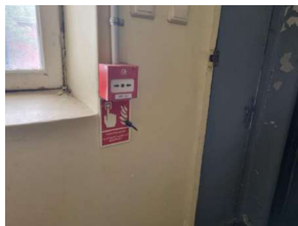
5.11.10. att. Ugunsgrēka atklāšanas un trauksmes signalizācijas sistēmas trauksmes poga
