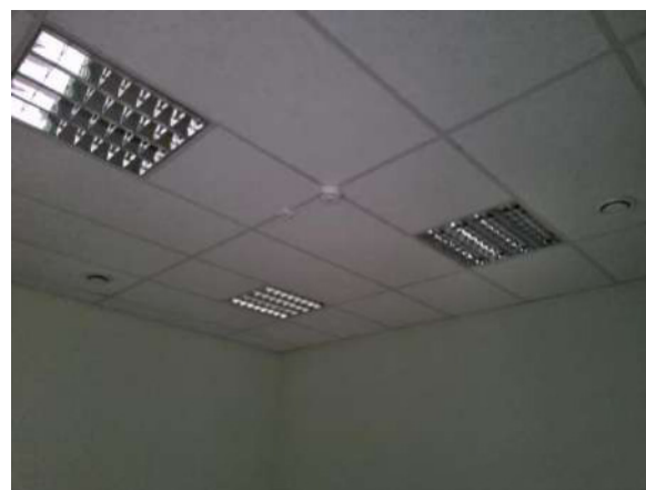
5.11.8. att. Ugunsgrēka atklāšanas un trauksmes signalizācijas sistēmas detektors
