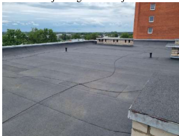
4.8.2.6. att. Padomju laika korpusa jumta segums
