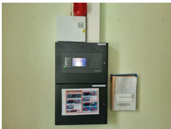
5.11.1. att. Ugunsgrēka atklāšanas un trauksmes signalizācijas sistēmas panelis
