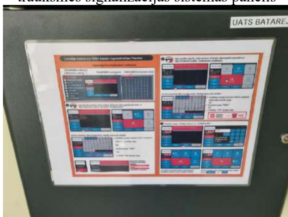
5.11.3. att. Ugunsgrēka atklāšanas un trauksmes signalizācijas sistēmas paneļa lietošanas instrukcija
