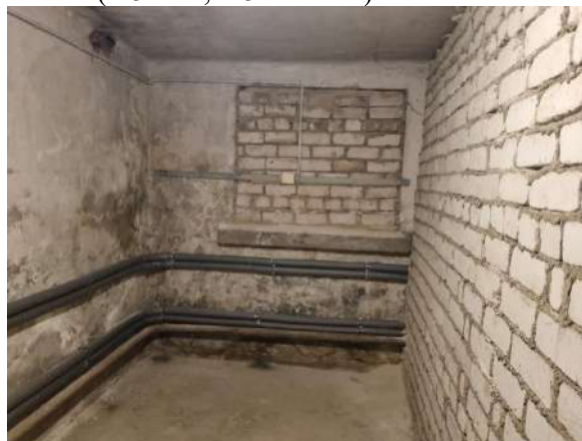
4.5.1.2. att. Mitruma ietekmē radīti pagrabstāva mūra sienas apdares bojājumi
