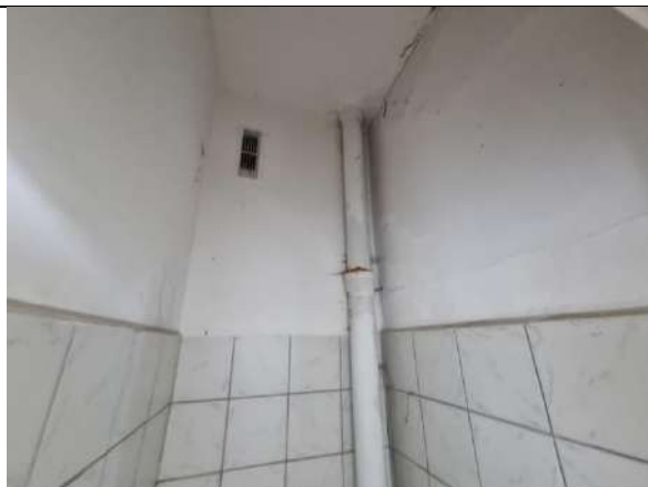
5.1.2.3. att. Nav veikta kanalizācijas stāvvada nomaīņa
