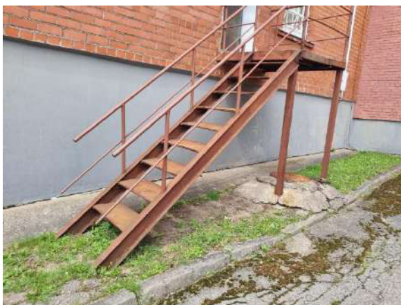
4.10.7. att. Ārējās evakuācijas kāpnes, virspusēja korozija
