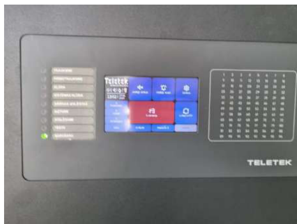
5.11.2. att. Ugunsgrēka atklāšanas un trauksmes signalizācijas sistēmas panelis
