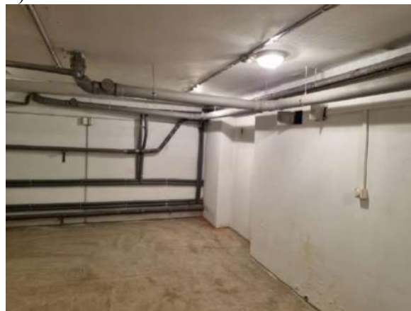
5.1.2.2. att. Veikta kanalizācijas guļvadu nomaina
