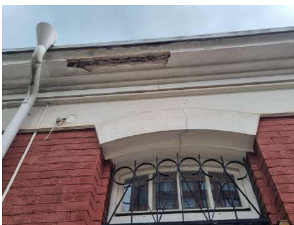
4.2.5.1. att. Ķieģeļu velvju pārsedze, nevienmērīgas sēšanās plaisa
