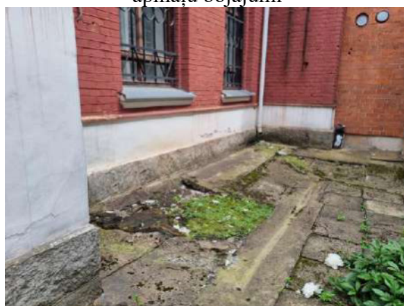
3.1.4. att. Betona plākšņu segums iekšpagalma pusē, segums nolietojies un aizaudzis ar zālāju
