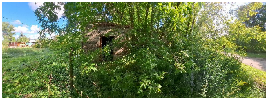
Hidrofora ēka, lit 001
