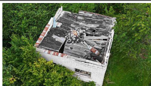
Būve-jaunbūve (dzīvojamās ēka-jaunbūve) ar kadastra apzīmējumu 6407 001 0045 001
