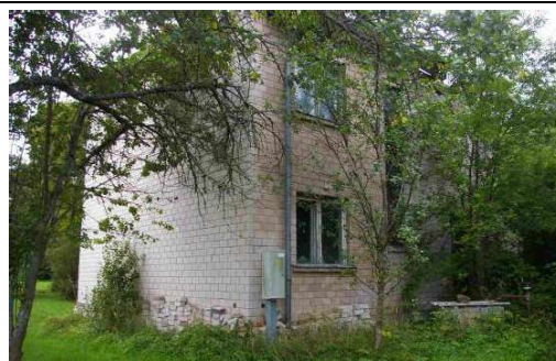
Būve-jaunbūve (dzīvojamās ēka-jaunbūve) ar kadastra apzīmējumu 6407 001 0045 001
