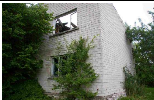
Būve-jaunbūve (dzīvojamās ēka-jaunbūve) ar kadastra apzīmējumu 6407 001 0045 001
