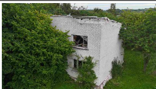
Būve-jaunbūve (dzīvojamās ēka-jaunbūve) ar kadastra apzīmējumu 6407 001 0045 001
