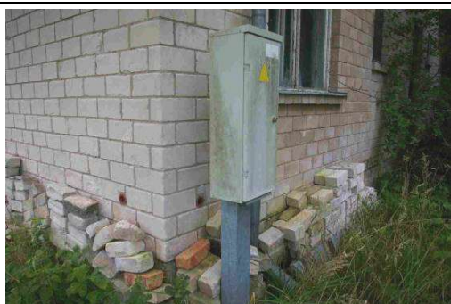
Būve-jaunbūve (dzīvojamās ēka-jaunbūve) ar kadastra apzīmējumu 6407 001 0045 001
