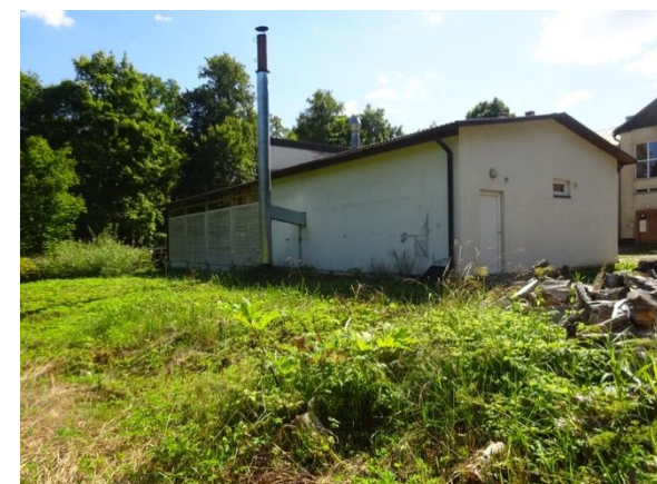
Apkures katla ēkas fasāde
