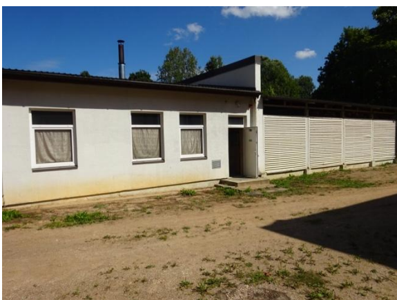
Apkures katla ēkas fasāde
