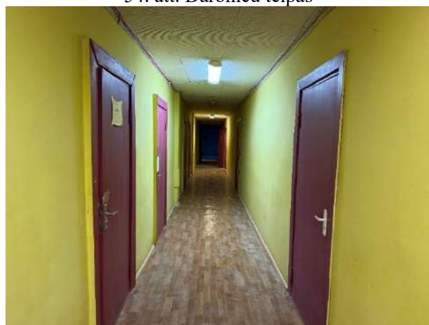
56. att. Ēkas 2. stāva gaitenis
