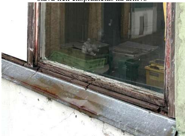
50. att. Koka logi nolietojušies, bojāti, ar zemu energoefektivitāti
