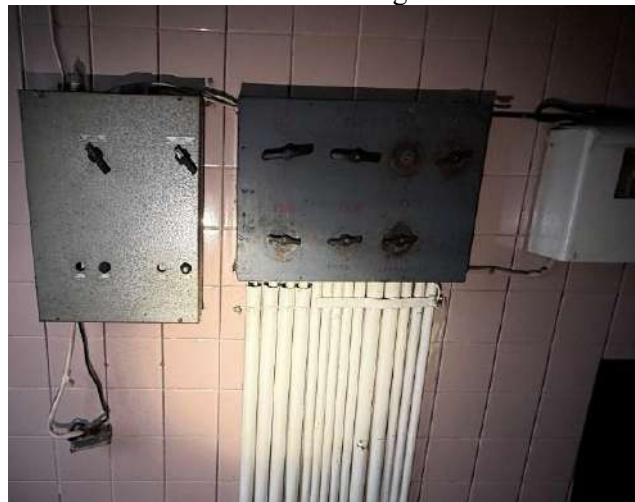
72. att. Eksploatācijā neesošas/atslēgtas elektroietaisies
