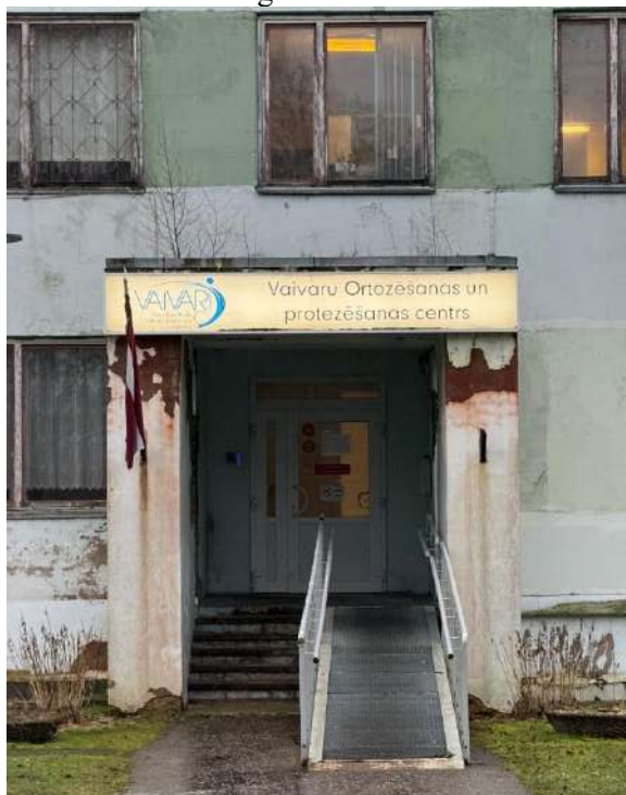
3.att. Galvenās ieejas lievenis – uz jumta iesauguši koki, atdalās apmetuma fragmenti
