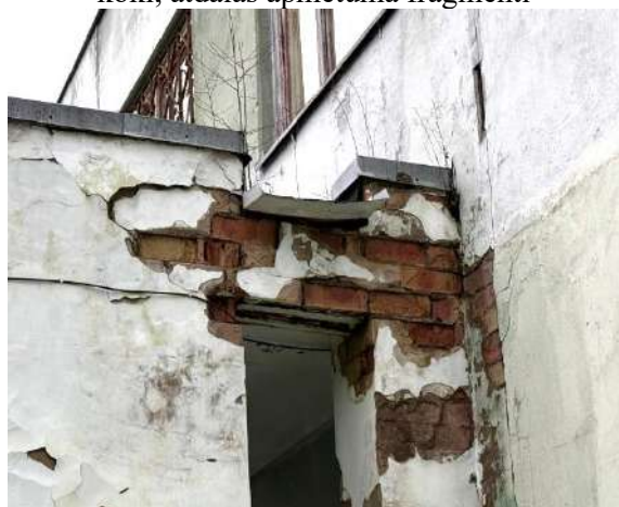
5.att. Galvenās ieejas lievenis – uz jumta iesauguši koki, atdalās apmetuma fragmenti
