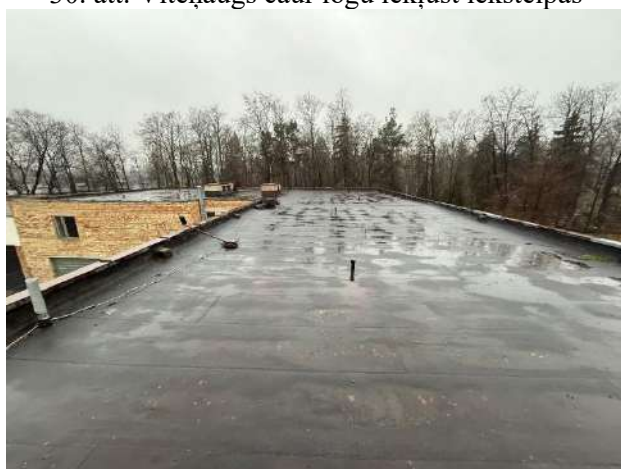
32. att. Ēkas jumts
