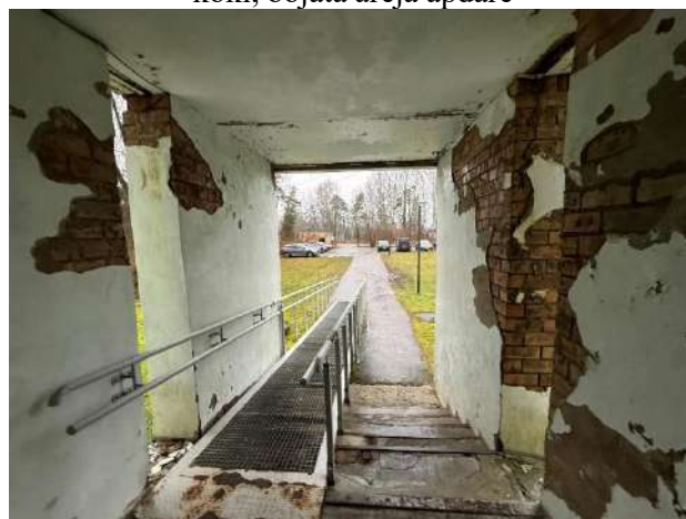
6.att. Galvenās ieejas lievenis – izteikti ārējās apdares bojājumi
