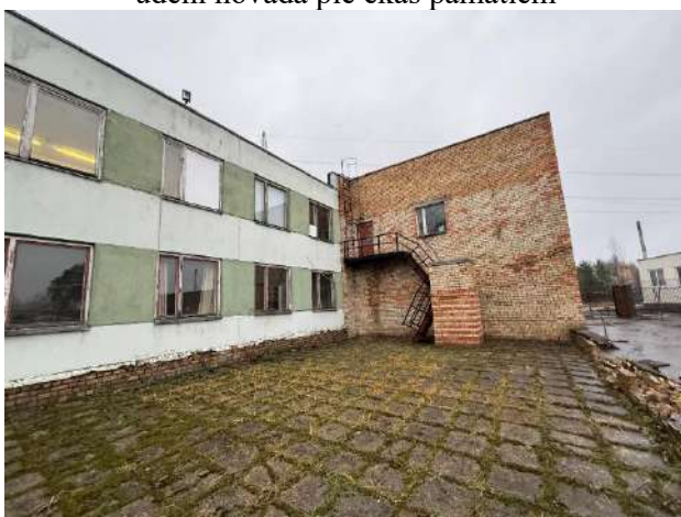
10.att. Ēkas aizmugures fasādes fragments
