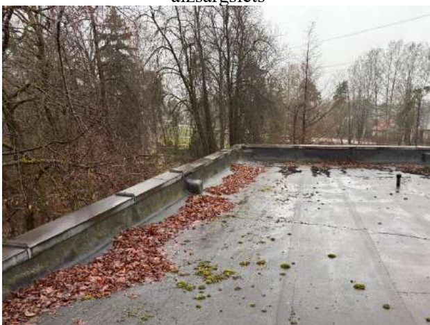
38. att. Uz jumta redzamas pēno lapu kaudzes, koka zari aizskar jumta parapetu
