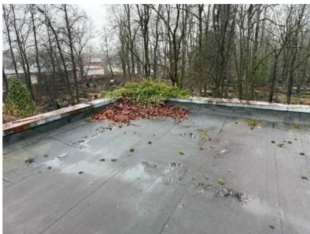
37. att. Vītenāugs uz jumta parapeta, uz jumta redzamas pēno lapu kaudzes
