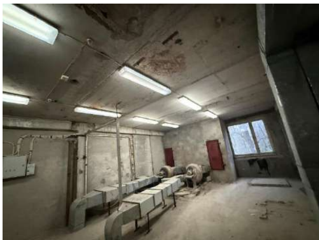
57. att. Ēkas 2. stāva tehniskā telpa
