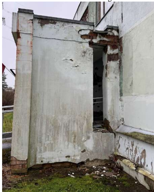
4.att. Galvenās ieejas lievenis – uz jumta iesauguši koki, bojāta ārējā apdare
