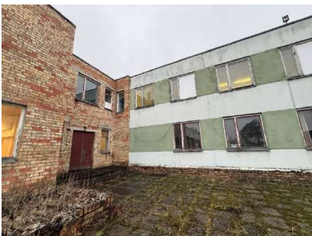
9.att. Ēkas aizmugures fasādes fragments
