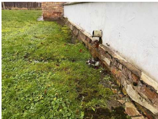
8.att. Lietus ūdens notekcaurules gals nokrišņu ūdeni novada pie ēkas pamatiem
