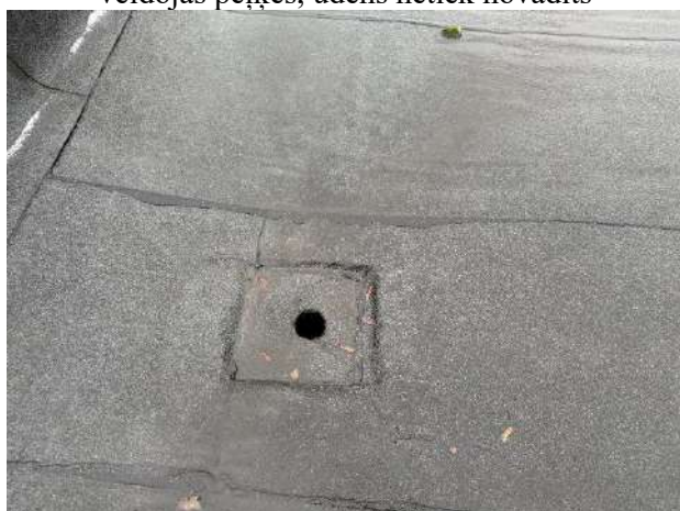
36. att. Lietus ūdens jumta gūlijai nav izbūvēts aizsargsiets
