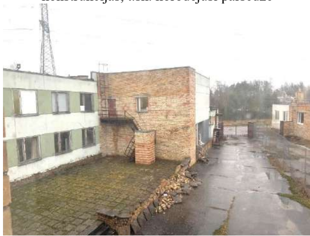
23. att. Skats uz ēkas aizmugures fasādēm
