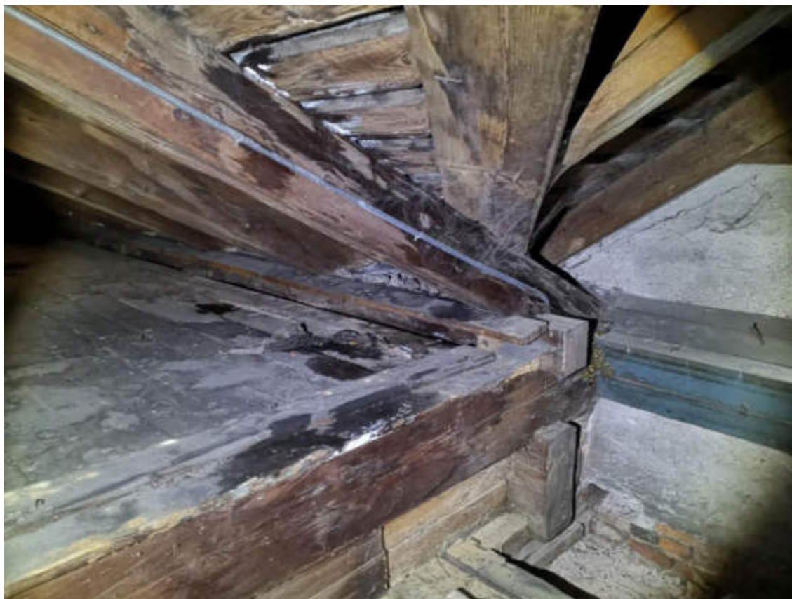
80.fotoattēls. Satecējumi uz jumta un pārseguma nesošajām konstrukcijām.
