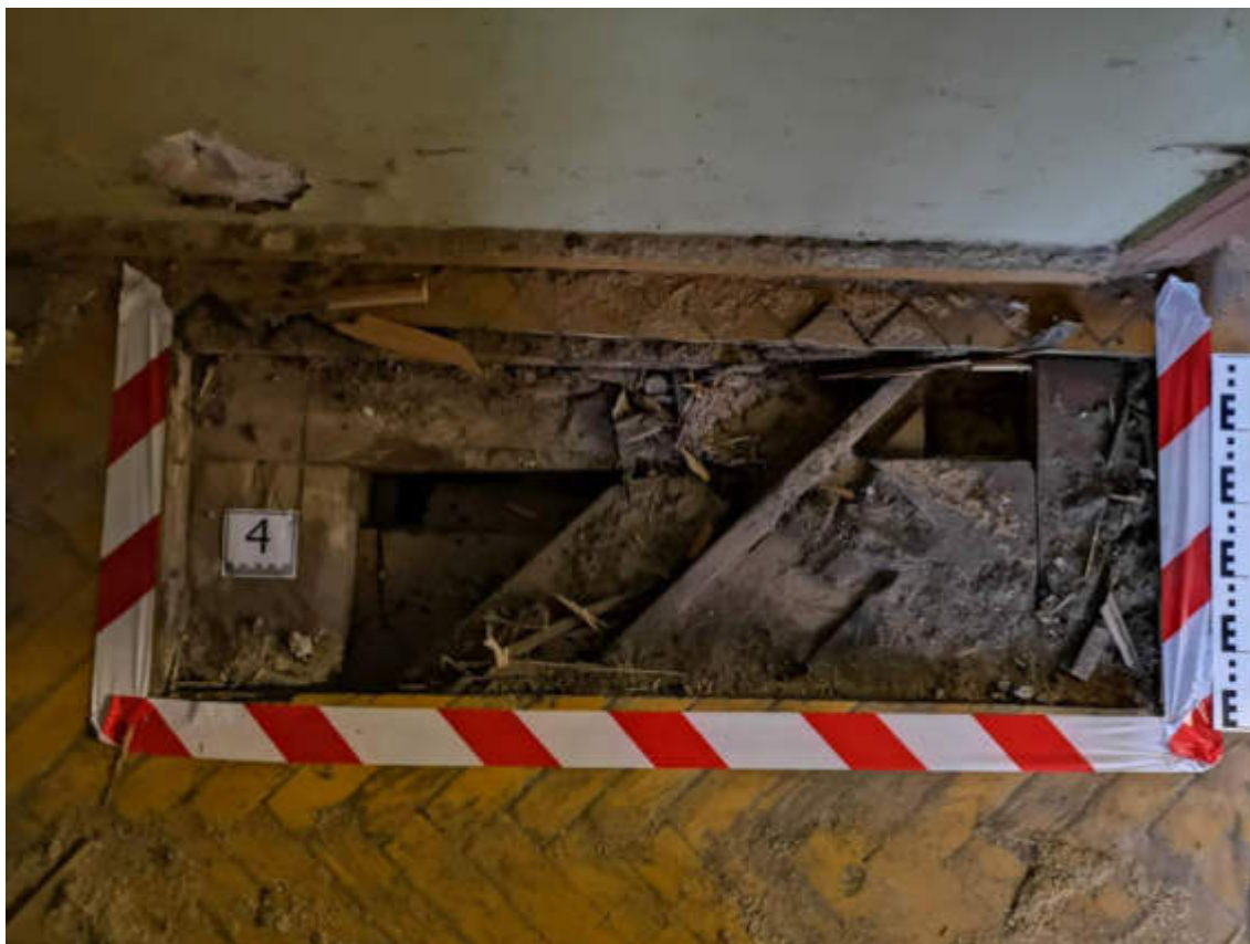
33.fotoattēls. 1.stāva pārseguma konstrukcijas atsegums
