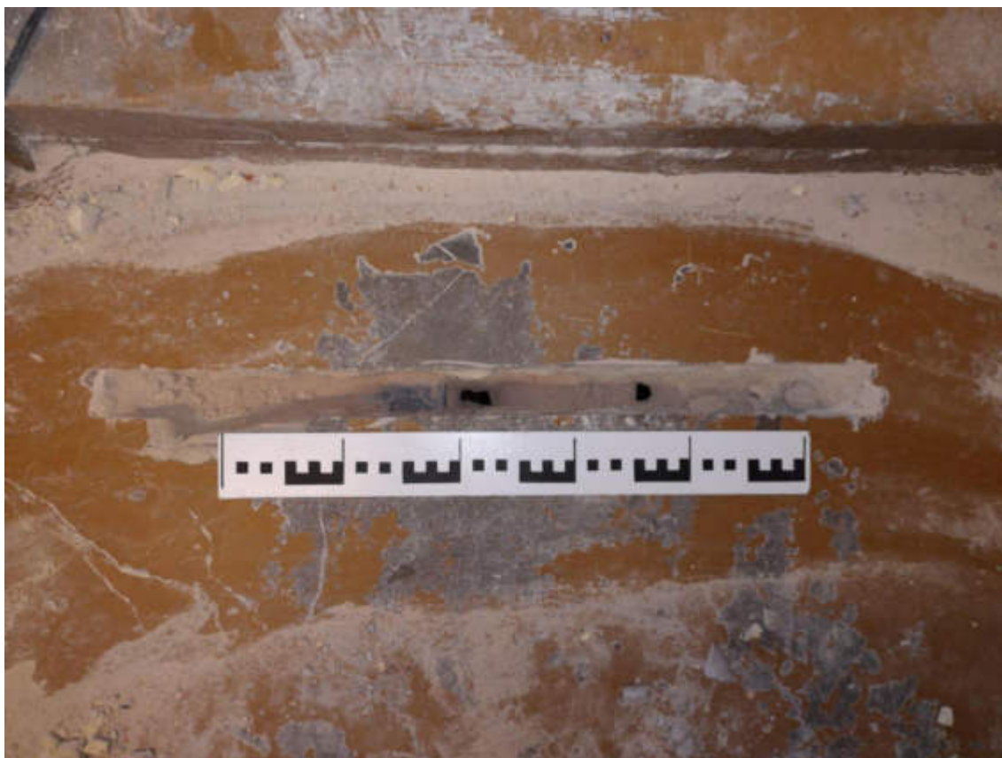
35.otoattēls. 1.stāva pārseguma konstrukcijas atsegums nr [5]
