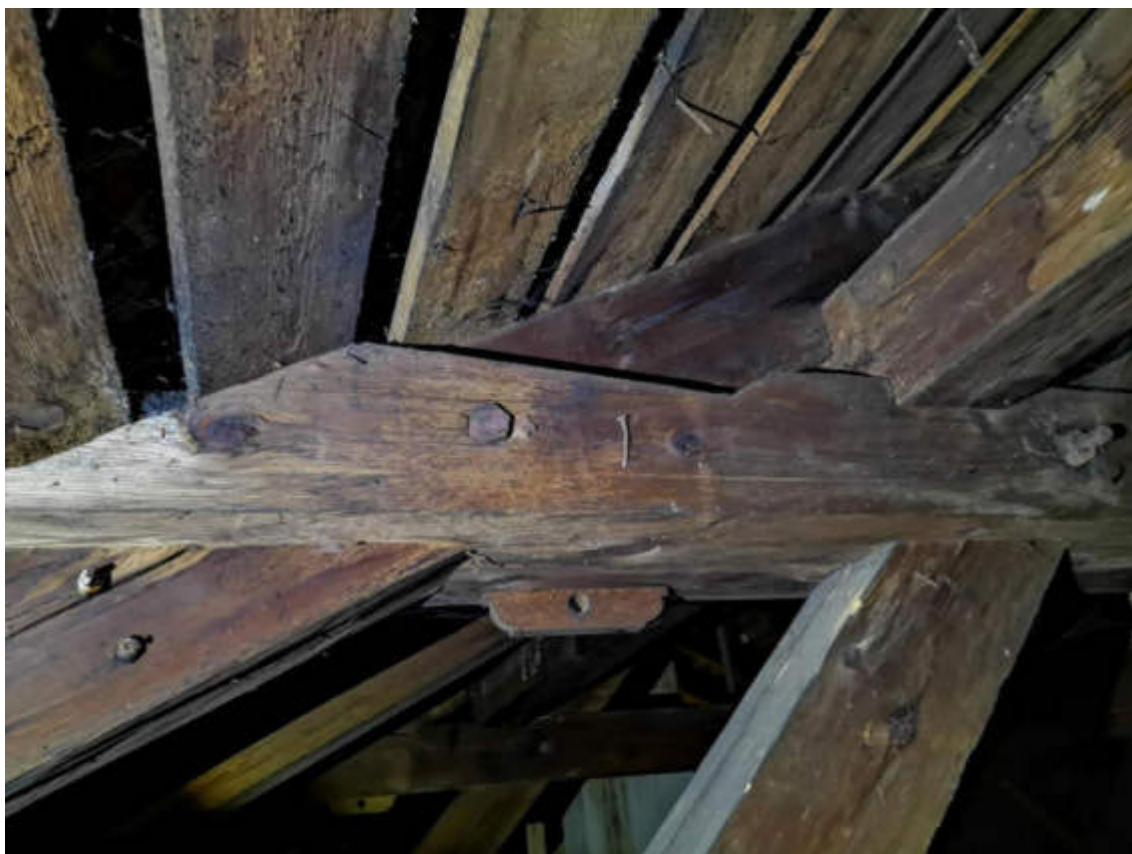
79.fotoattēls. Saišķa un augšējā koptura, kā arī slīpā jumta krēsla stata savienojuma mezgls ar bultskrūvēm.
