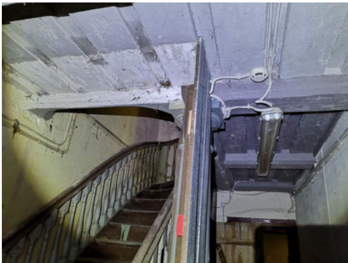
74.fotoattēls. Kāpņu K-2 izmijas konstrukcija. Balstošā koka kolonna
