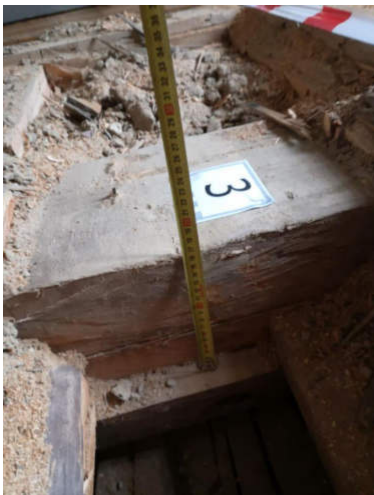
32.fotoattēls. 1.stāva pārseguma konstrukcijas atsegums
