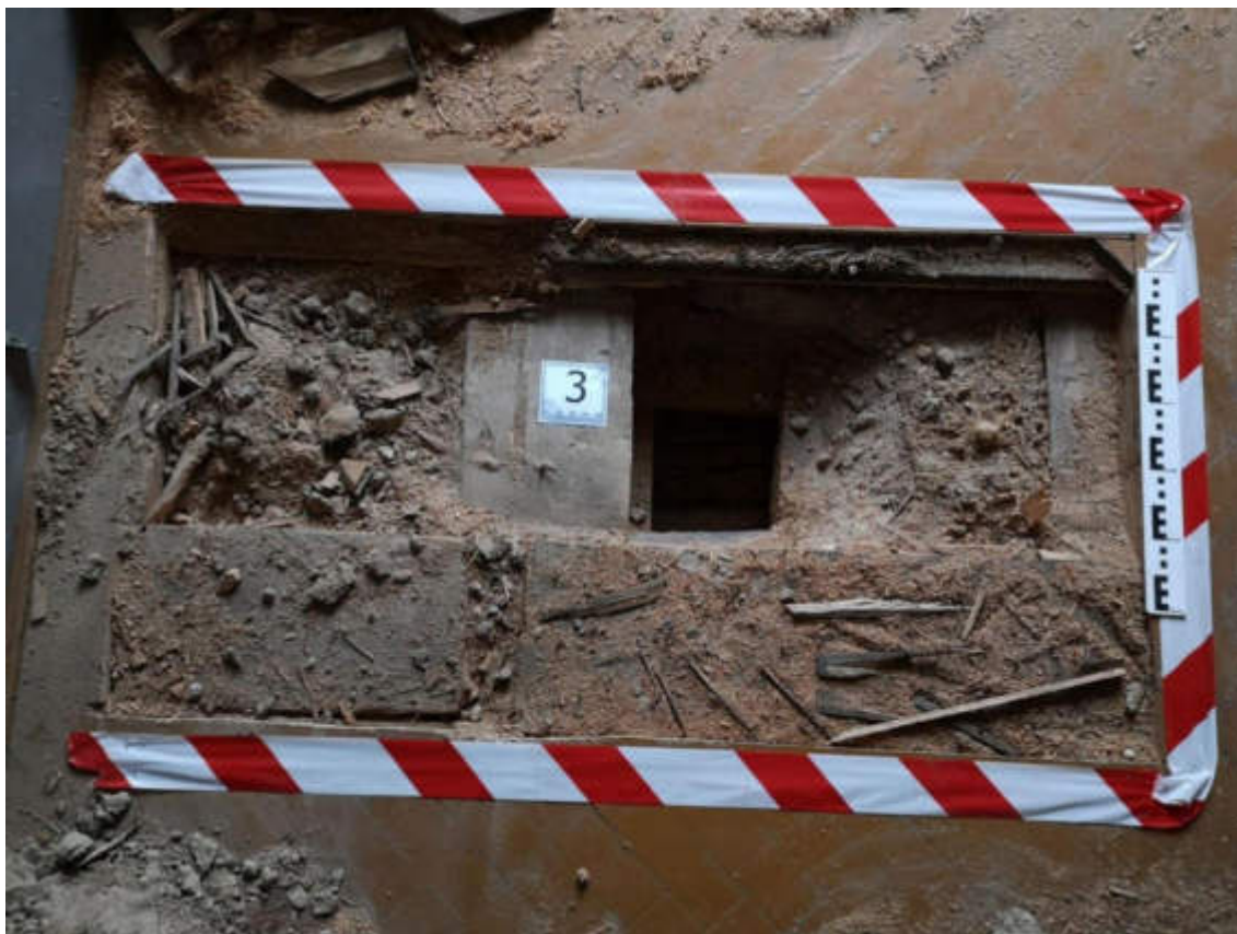
31.fotoattēls. 1.stāva pārseguma konstrukcijas atsegums
