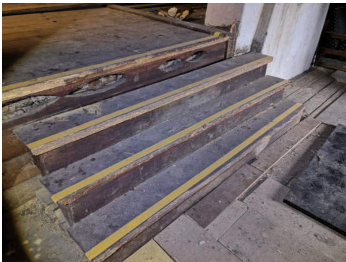
104.fotoattēls. Kāpņu konstrukcija uz līmeni virs svētnu zāles griestiem.
