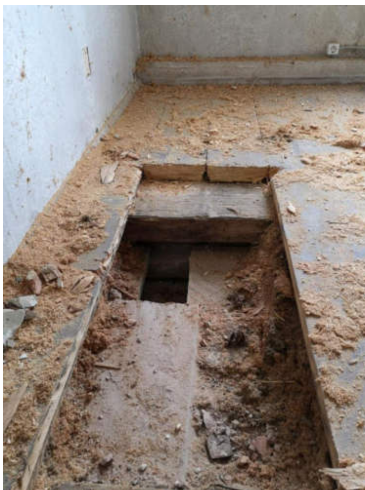
28.fotoattēls. 1.stāva pārseguma konstrukcijas atsegums
