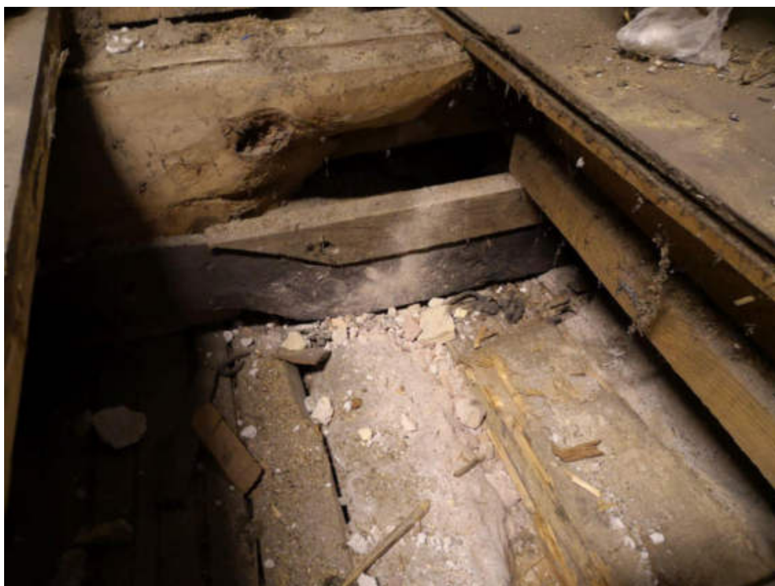
52.fotoattēls. Pārseguma siju galu savienojums ar kalnu metāla elementu
