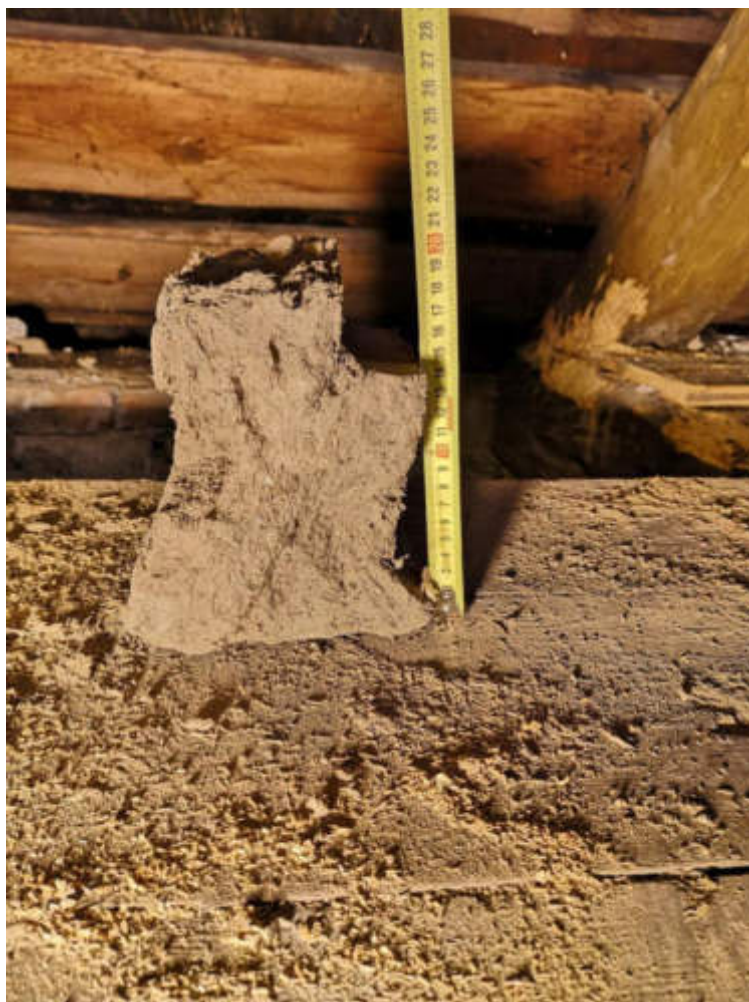
56.fotoattēls. Pārseguma aizbēruma fragments. Ļoti blīvs skaidu un kaļķu javas maisījums
