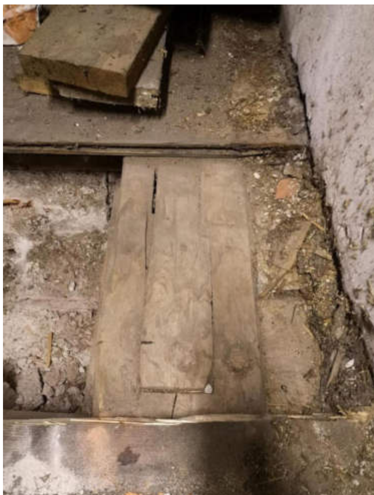
54.fotoattēls. Pārseguma siju galu savienojums 1/3b ar sazobi un koka tapām
