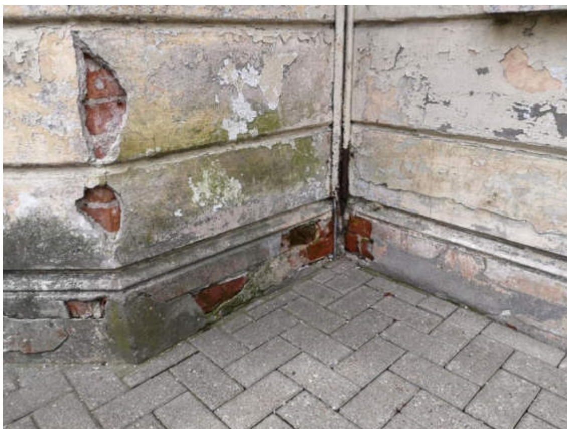
178.fotoattēls. Apmetuma fragmentu zudumi. Cokola bioerozija.
