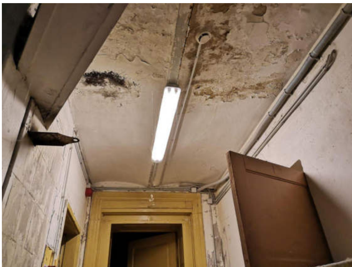
68.fotoattēls. Erodējies 2.stāva prūšu velvju pārseguma mūrējums
