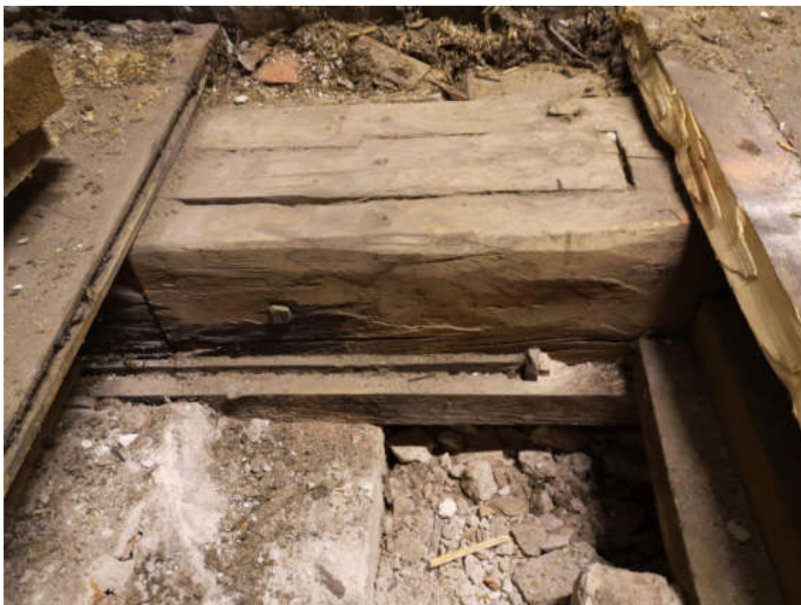
53.fotoattēls. Pārseguma siju galu savienojums 1/3b ar sazobi un koka tapām
