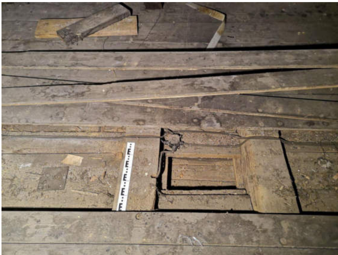
47.otoattēls. 2.stāva pārseguma (svētku zāles) konstrukcijas atsegums
