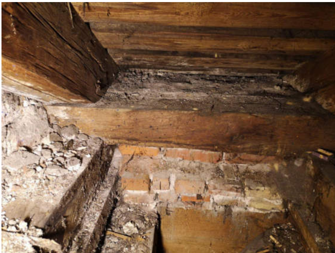
61.otoattēls. 2.stāva pārseguma konstrukciju balstmezgla atsegums
