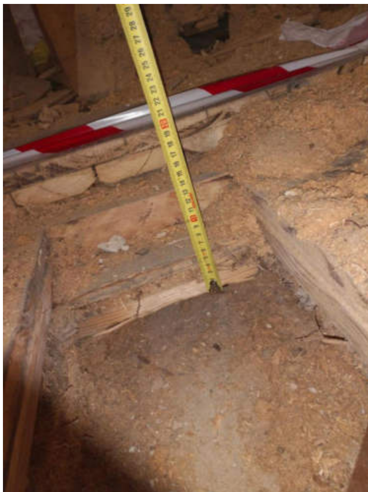
46.fotoattēls. 1.stāva pārseguma konstrukcijas atsegums
