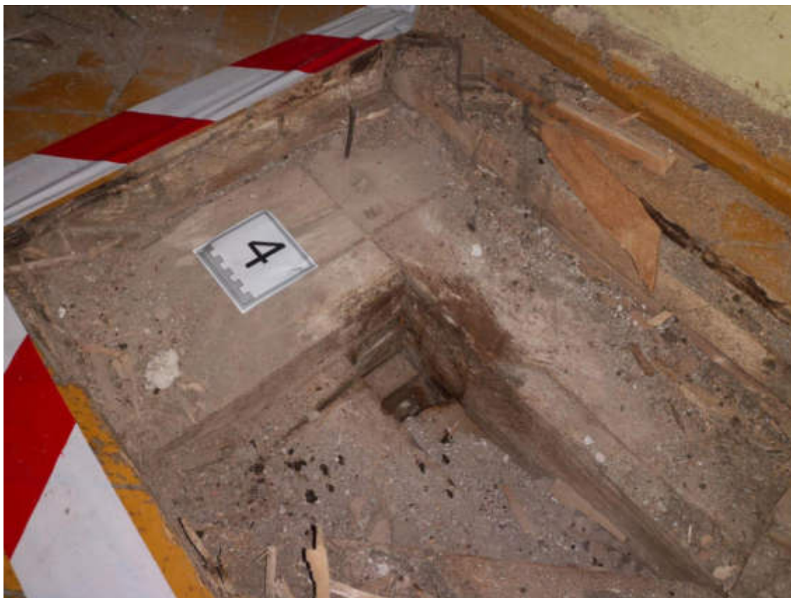
34.fotoattēls. 1.stāva pārseguma konstrukcijas atsegums
