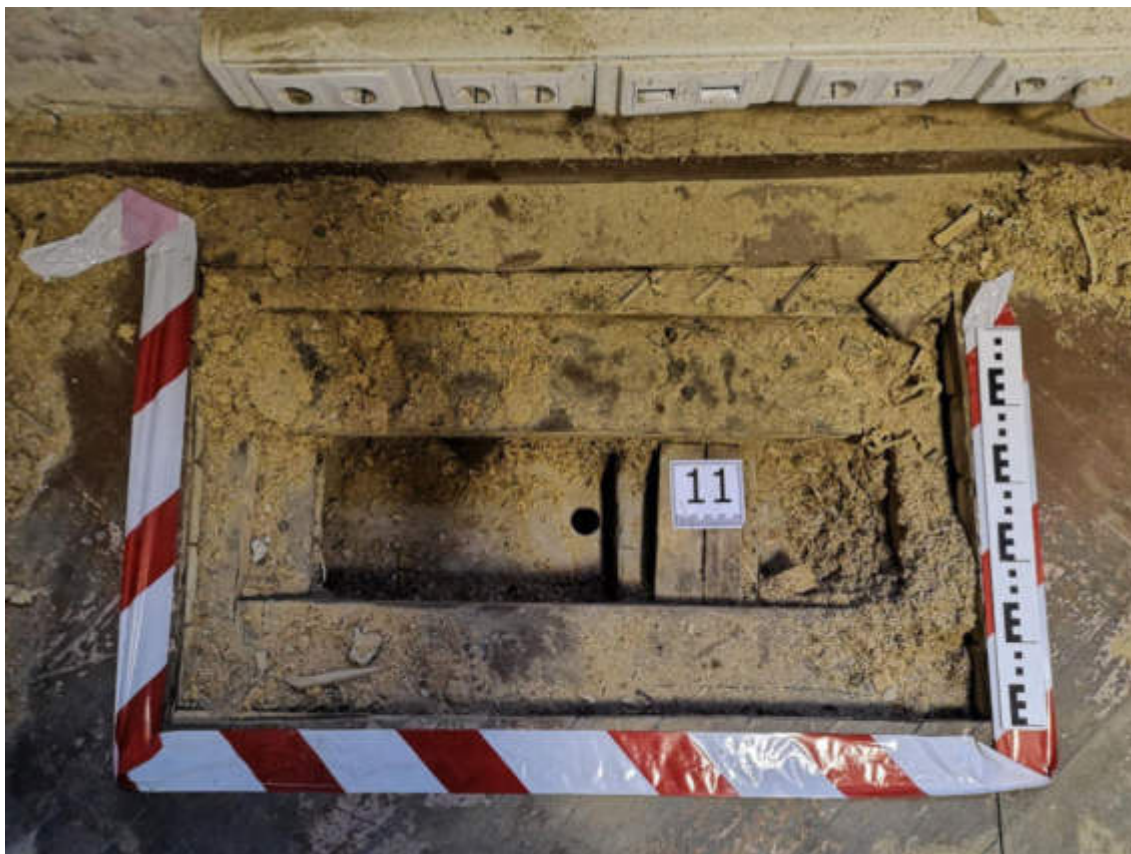
45.fotoattēls. 1.stāva pārseguma konstrukcijas atsegums
