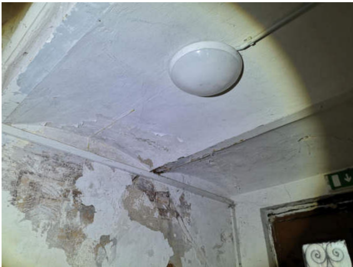
67.fotoattēls. Korodējuši prūšu velvju siju apakšējie plaukti
