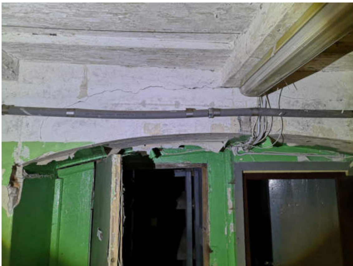
69.fotoattēls. Plaša 1.stāva siju griestu pārsedzē
