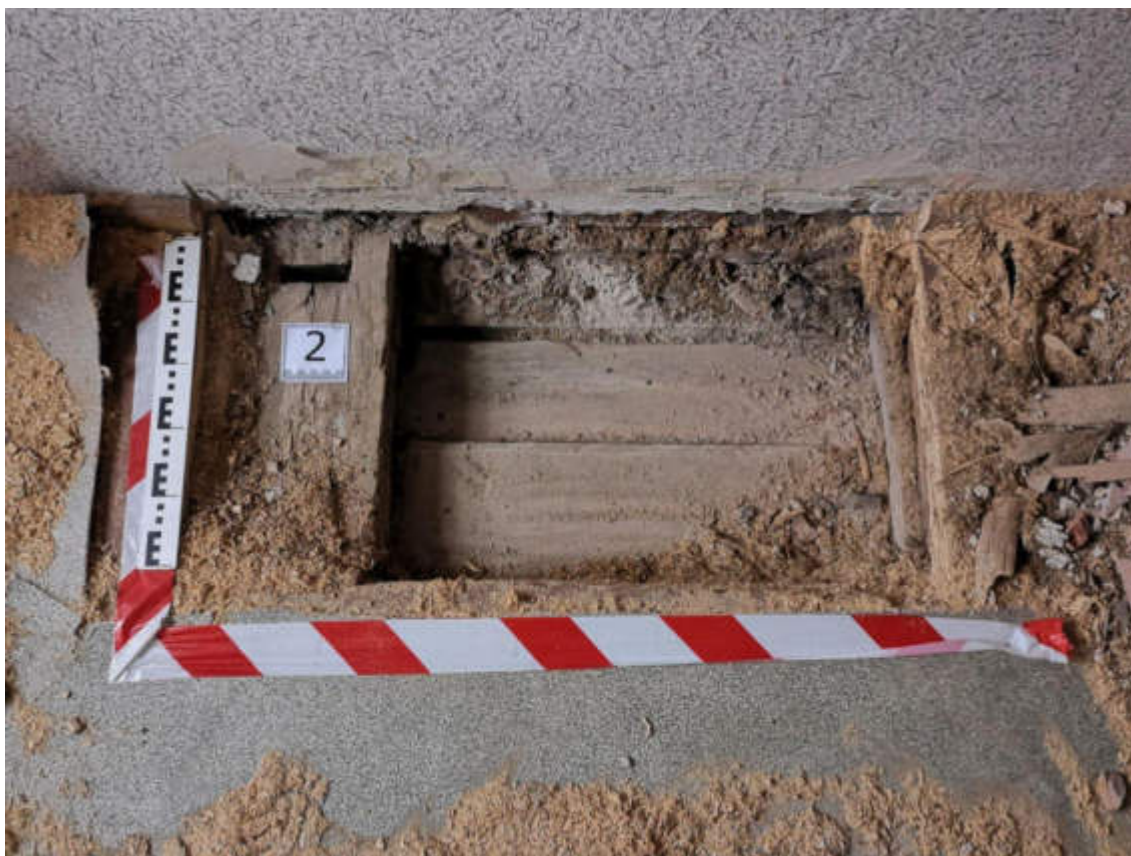
29.fotoattēls. 1.stāva pārseguma konstrukcijas atsegums
