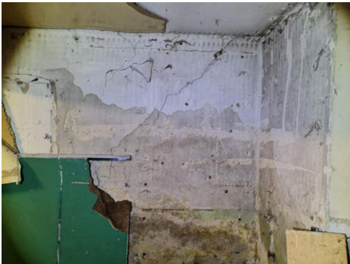
145.fotoattēls. Sēšanās radītas plaisas mūra iekšsienā.
