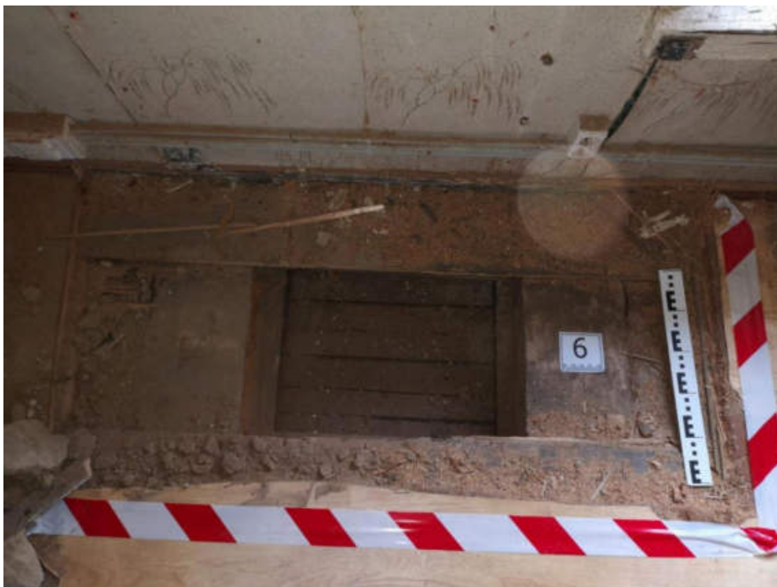
37.fotoattēls. 1.stāva pārseguma konstrukcijas atsegums
