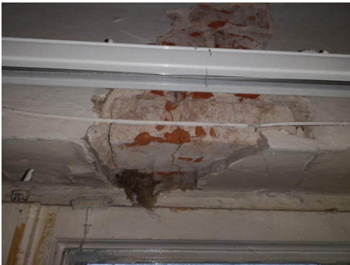
19.fotoattēls. Logailu pārsedzes atsegums [p10]
