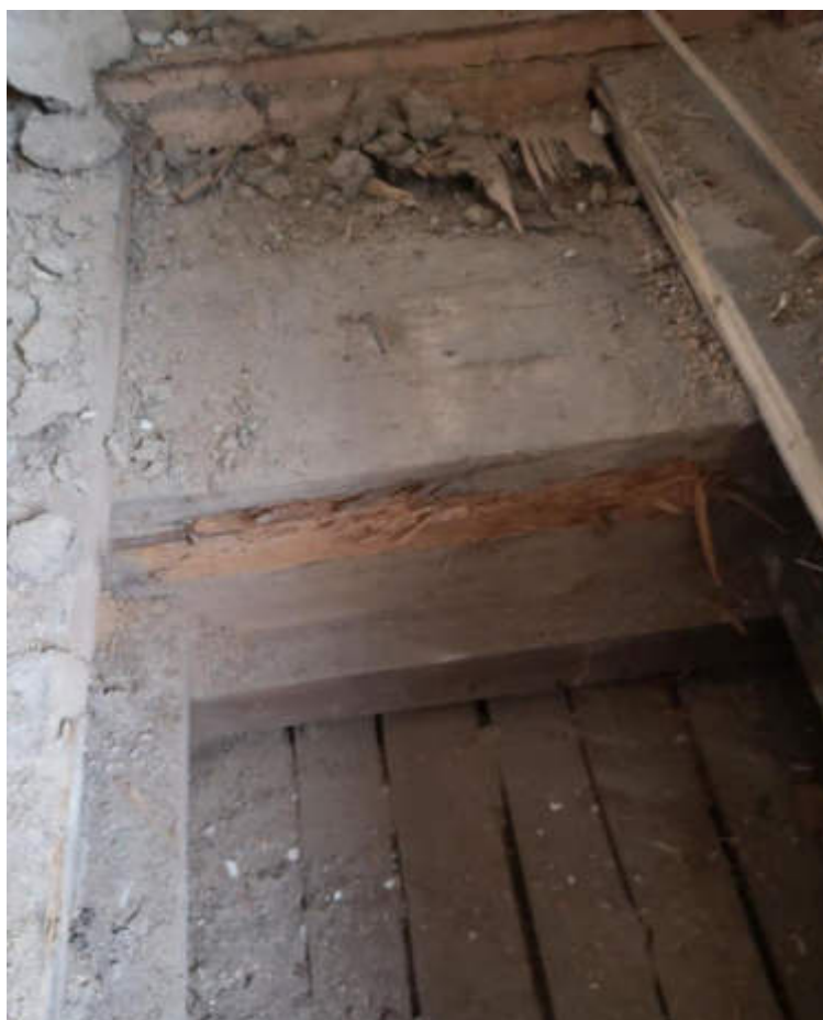
38.fotoattēls. Trupējušas pārseguma sijas
