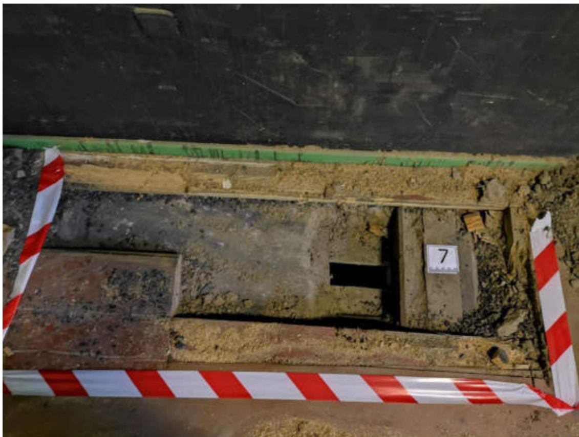
39.fotoattēls. 1.stāva pārseguma konstrukcijas atsegums
