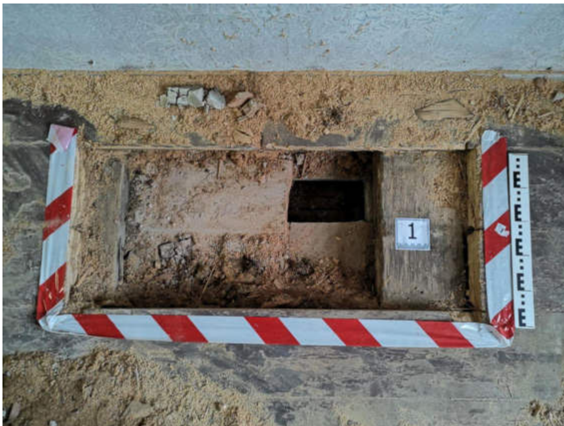
27.fotoattēls. 1.stāva pārseguma konstrukcijas atsegums
