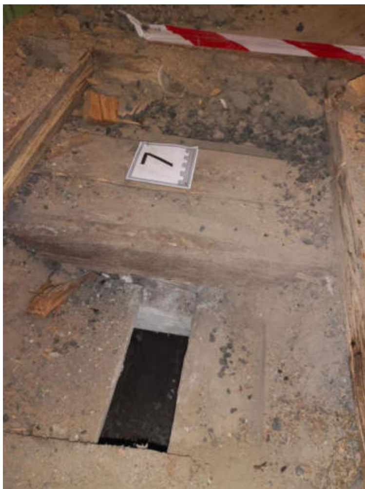
40.fotoattēls. 1.stāva pārseguma konstrukcijas atsegums
