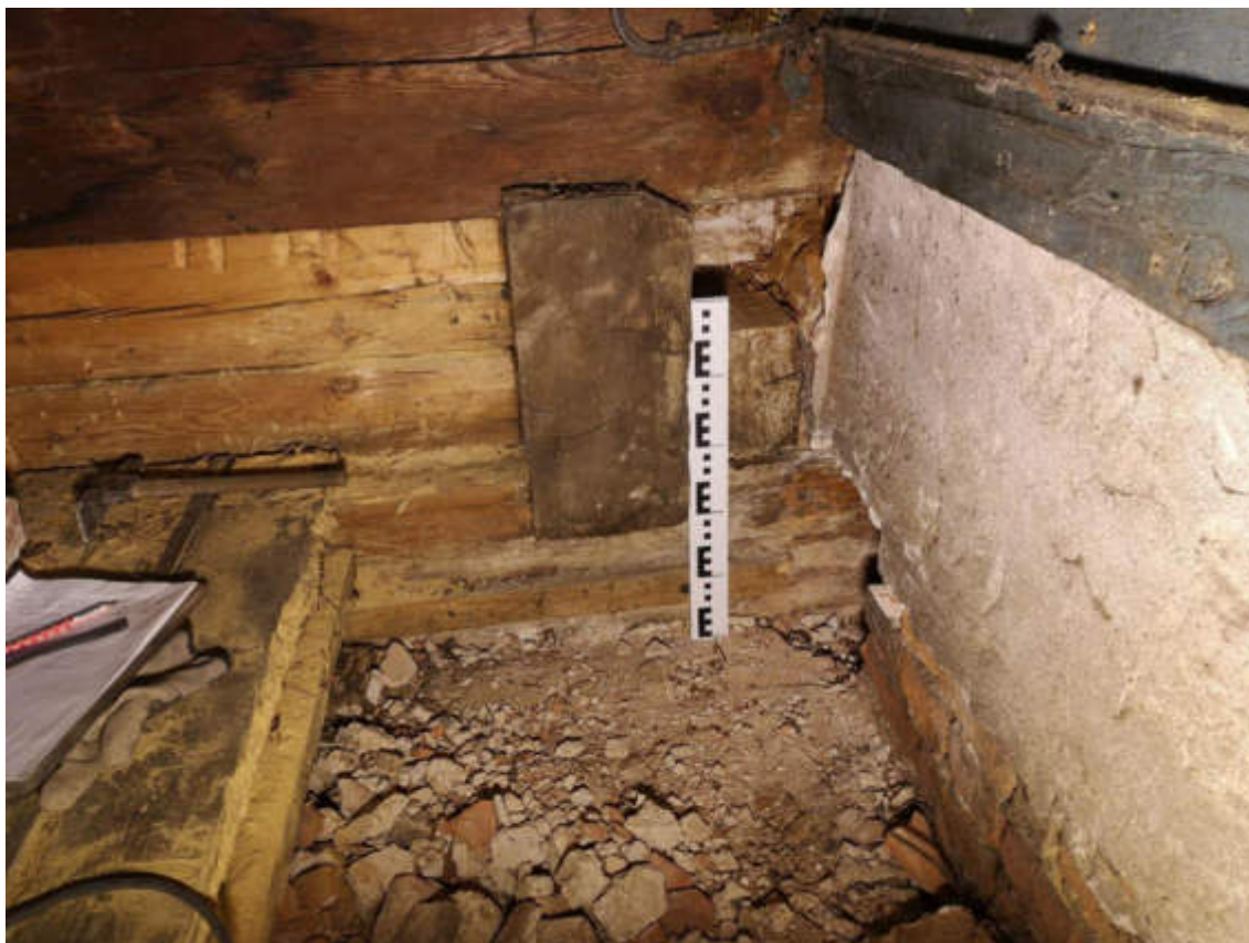
57.fotoattēls. 2.stāva pārseguma konstrukciju balstmezgla atsegums
