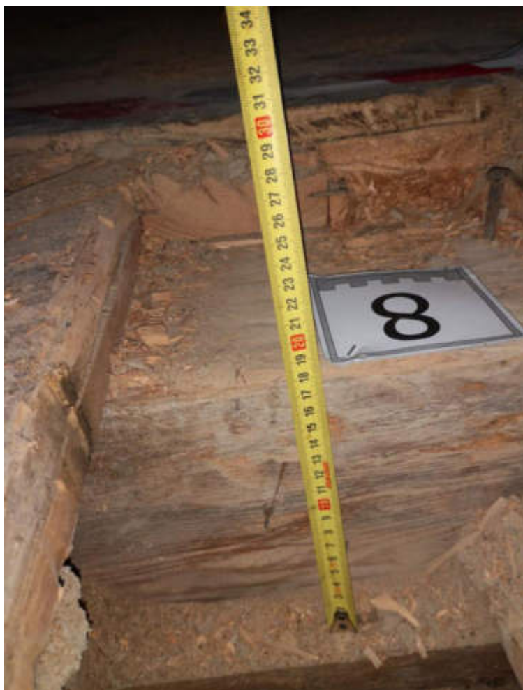
42.fotoattēls. 1.stāva pārseguma konstrukcijas atsegums
