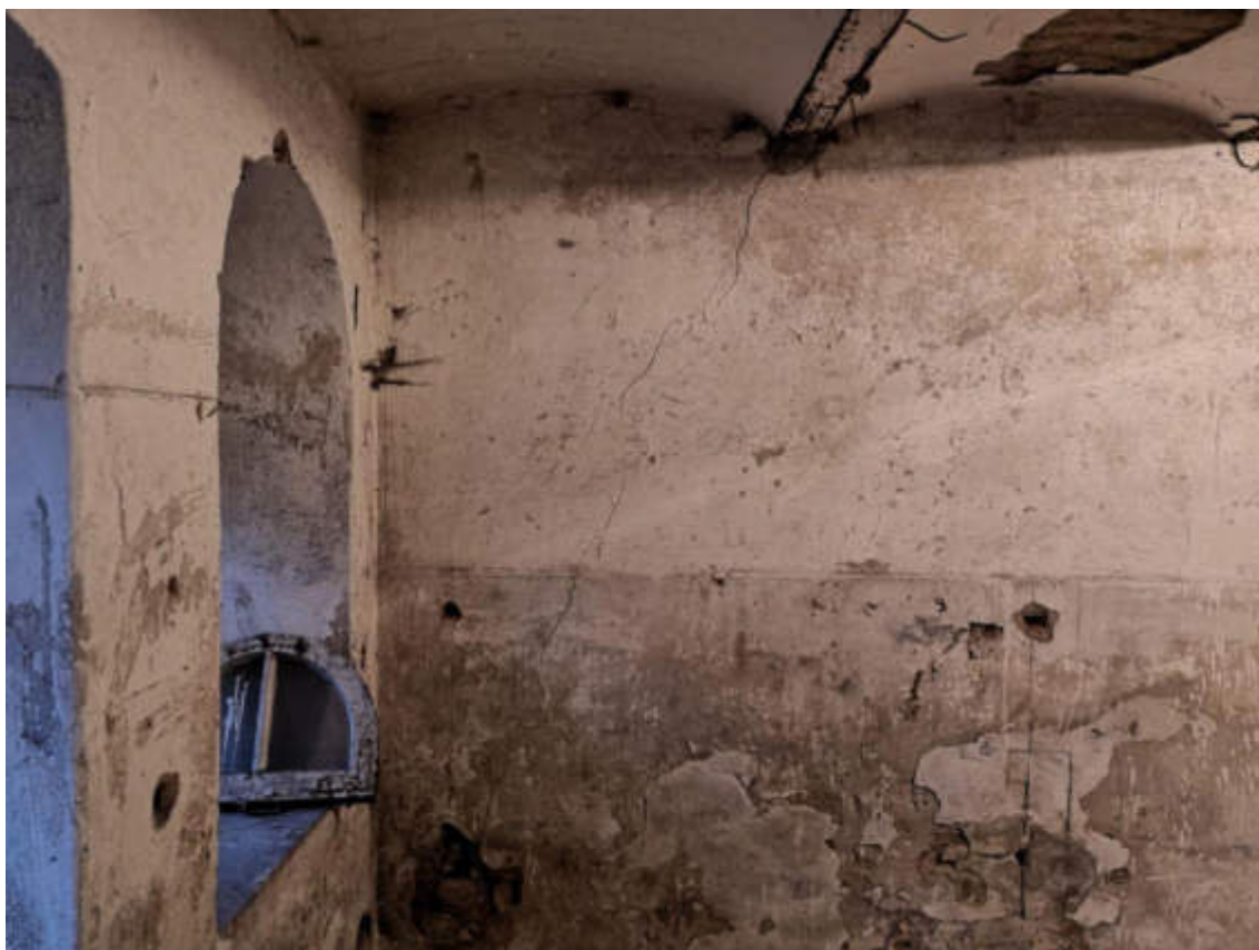
65.fotoattēls. Ārsienas sēšanās vai sala izcilāšanas plaša.
