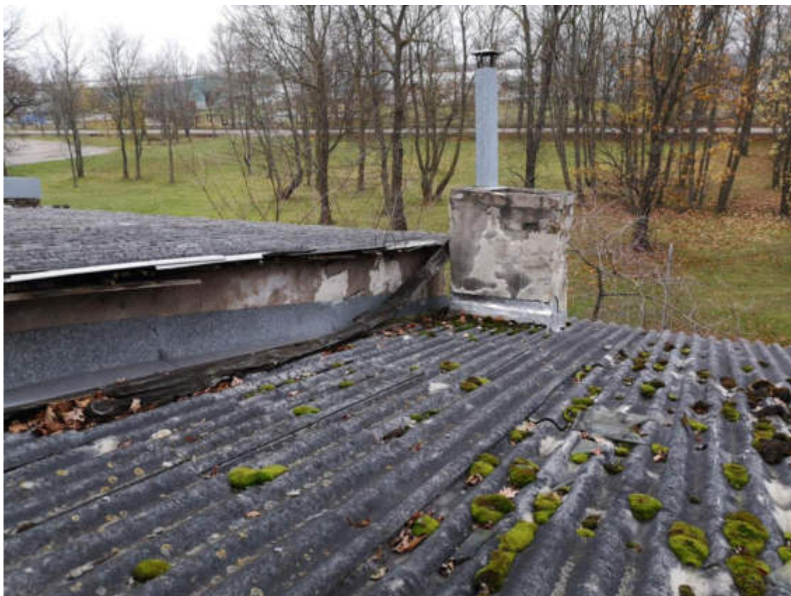
115.fotoattēls. B1 korpusa jumta segums un dūmeņu galvas blīvējums.
