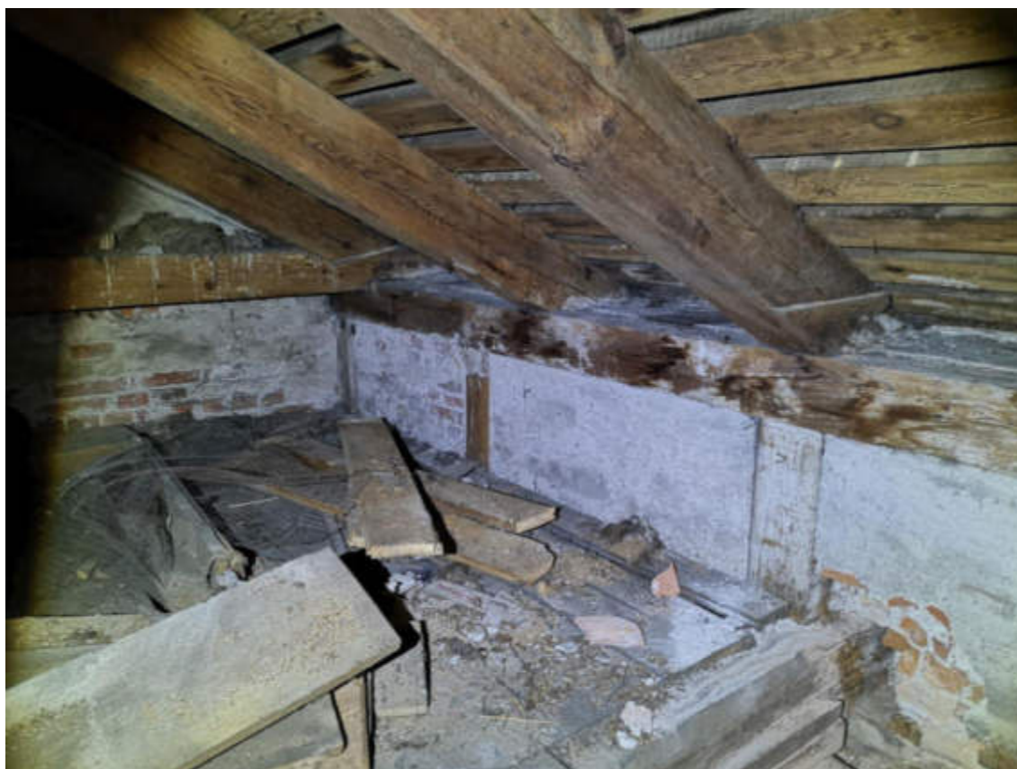
78.fotoattēls. Jumta drempeļa konstrukcija un spāru balstmezgli.
