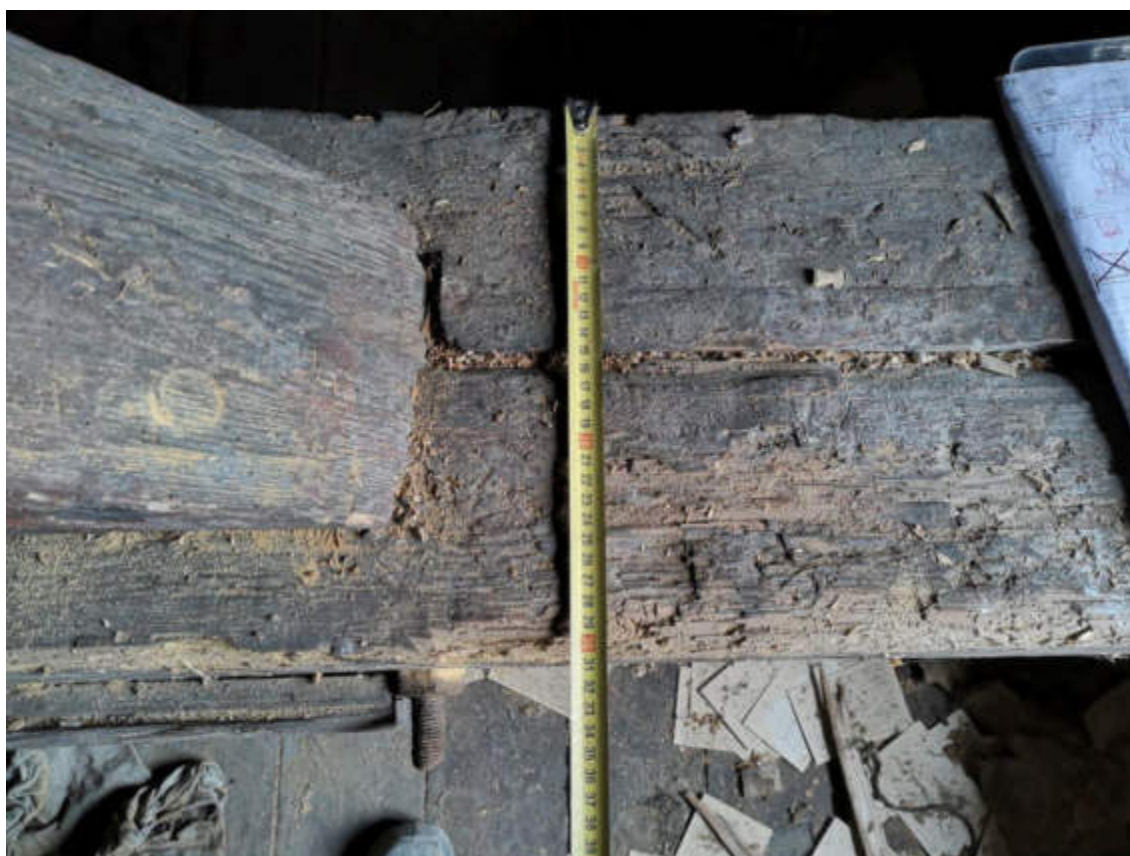
82.fotoattēls. Apakšējā saišķa un slīpā krēsla stata savienojums.
