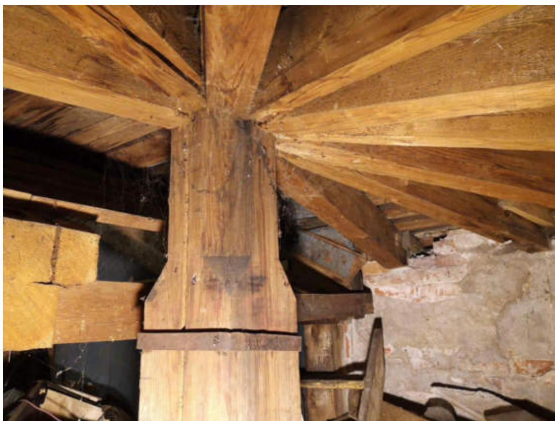
108.fotoattēls. Rizālīta daļas jumta nesošais stats.
