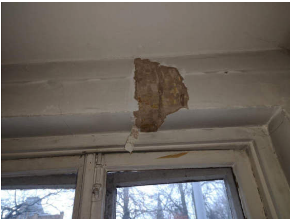
23.fotoattēls. Logailu pārsedzes atsegums [p8]
