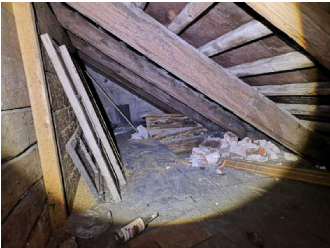
103.fotoattēls. C korpusa jumta konstrukcijas pažobelē.
