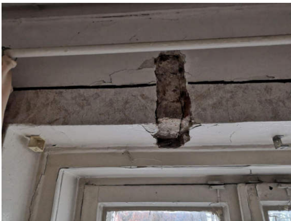
20.fotoattēls. Logailu pārsedzes atsegums [p7]
