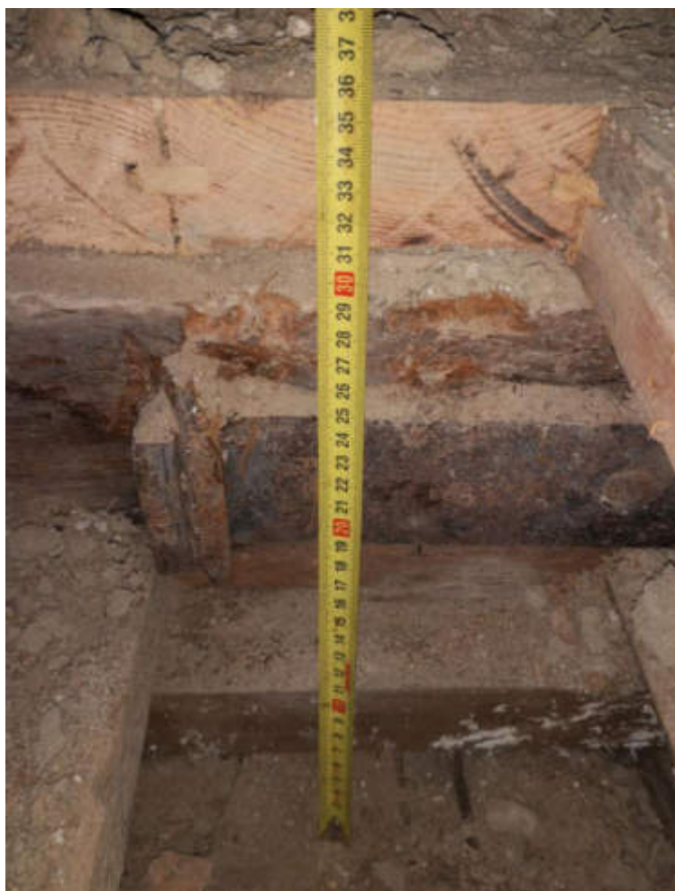
44.fotoattēls. Pārseguma siju galu enkurojums
