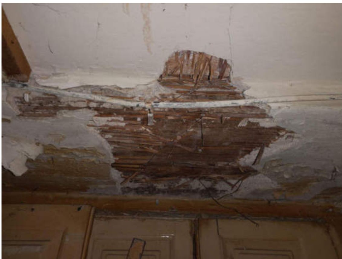
14.fotoattēls. Logailu pārsedzes atsegums [p1]
