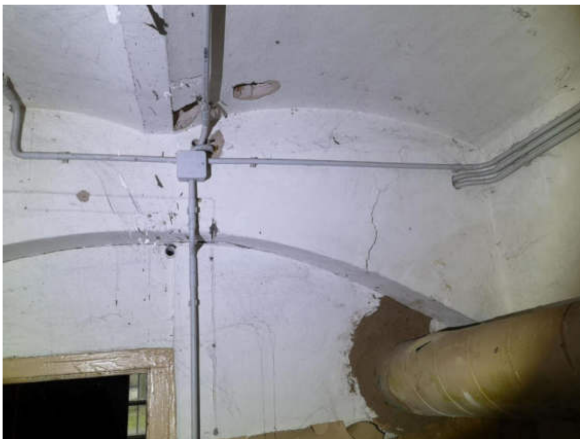
36.fotoattēls. 1.stāva pārseguma konstrukcijas atsegums
