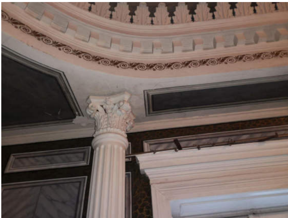
25.fotoattēls. Svētku zāles griestu konstrukcijas balstošā metāla kolonna
