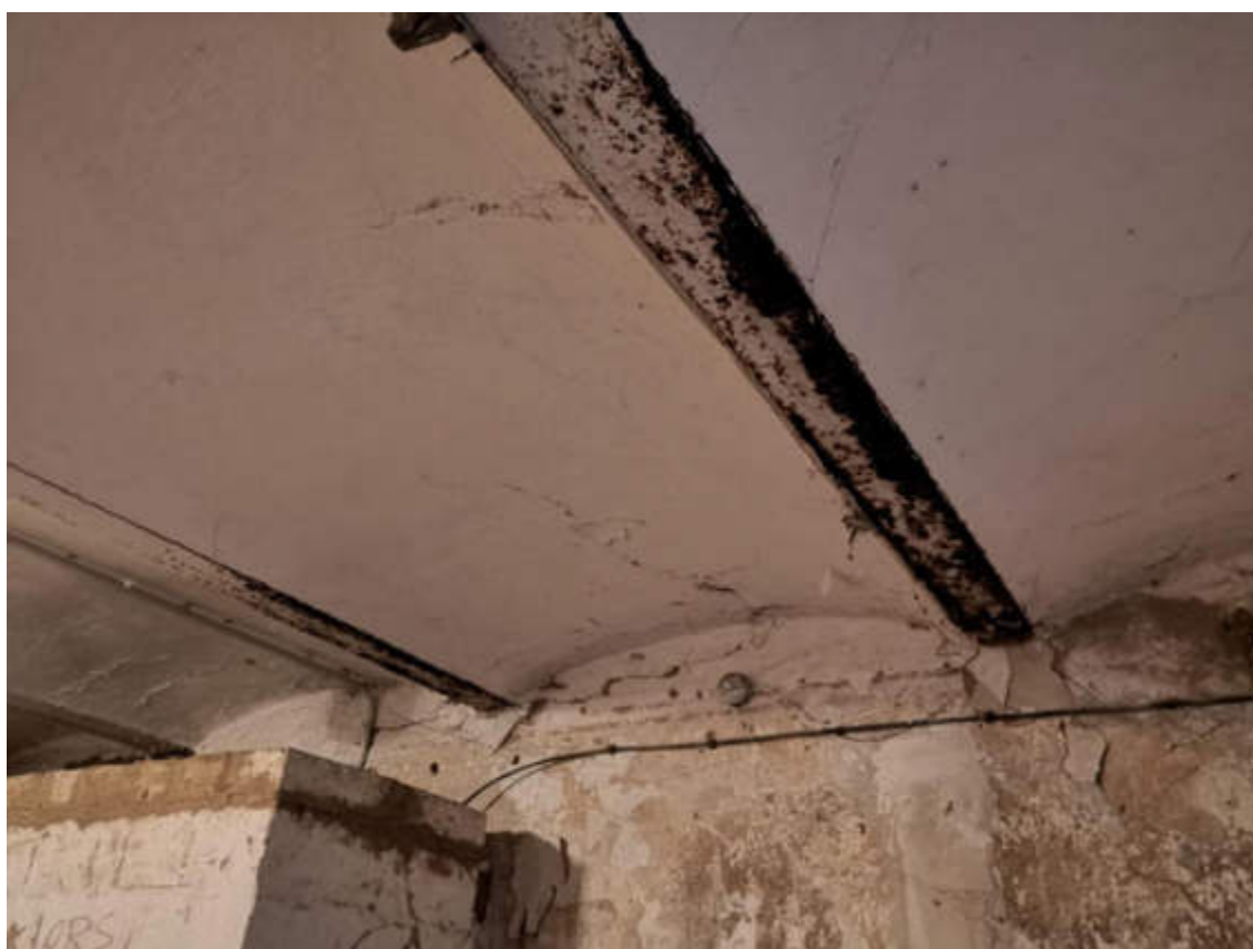
64.fotoattēls. Atslāņojušies prūšu velvju siju apakšējie plaukti
