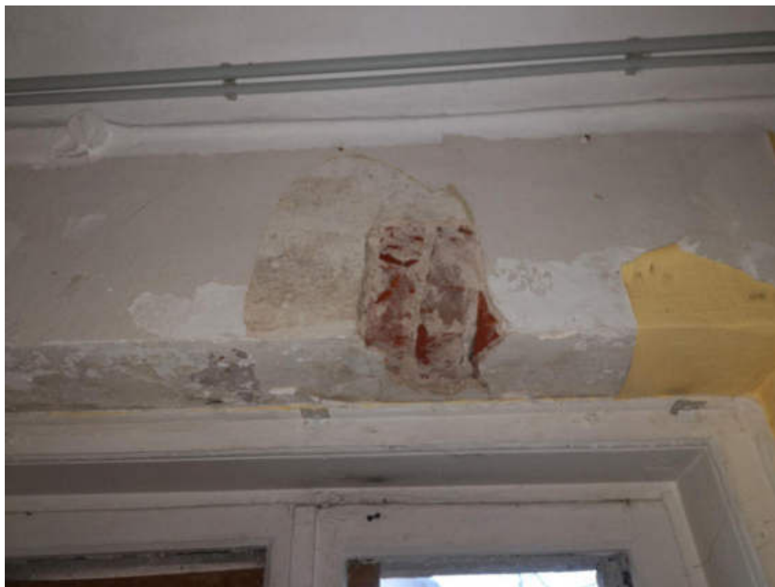
22.fotoattēls. Logailu pārsedzes atsegums [p9]
