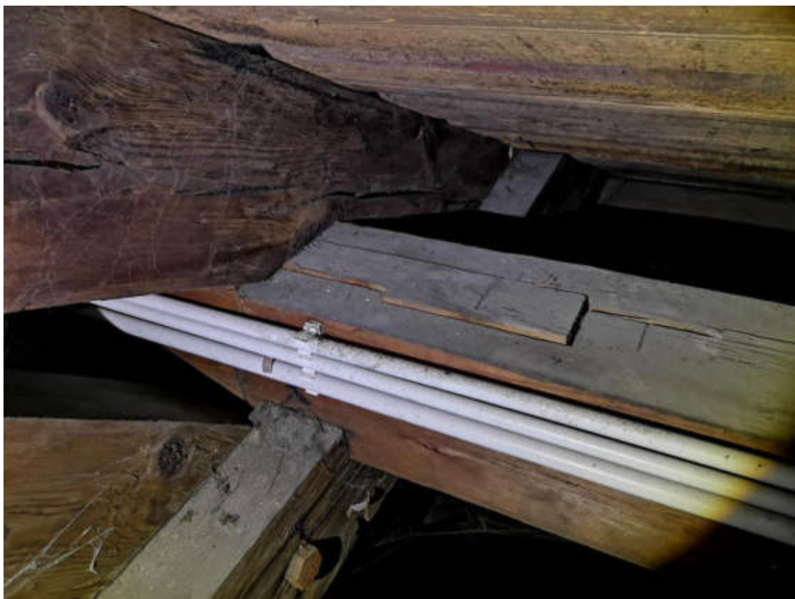
83.fotoattēls. Augšējā koptura pagarinājums puskokā ar sazobi
