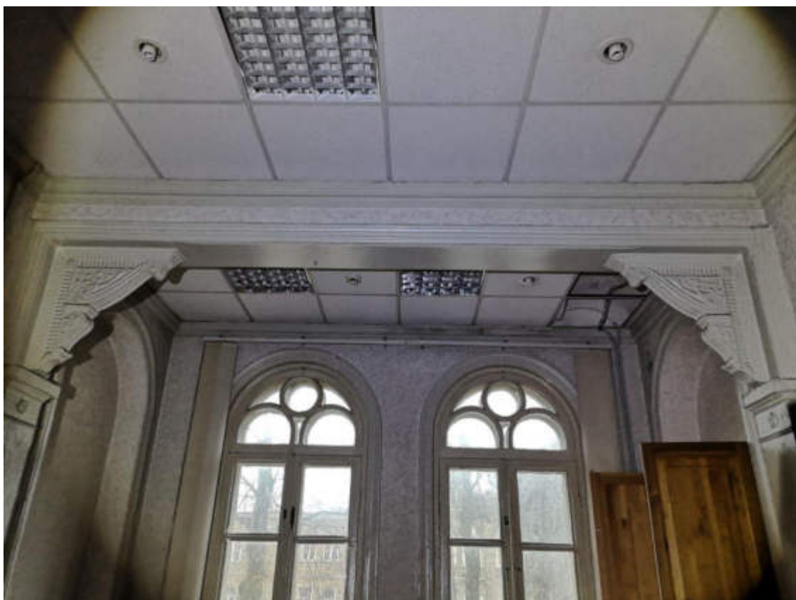
77.fotoattēls. Rizalīta daļas pārseguma pasija.
