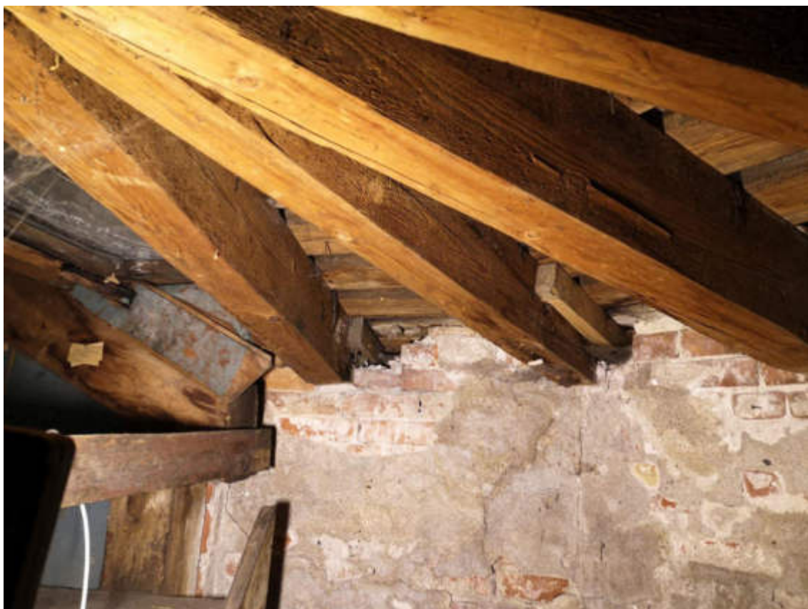
107.fotoattēls. Rizālīta daļas jumta nesošās konstrukcijas.
