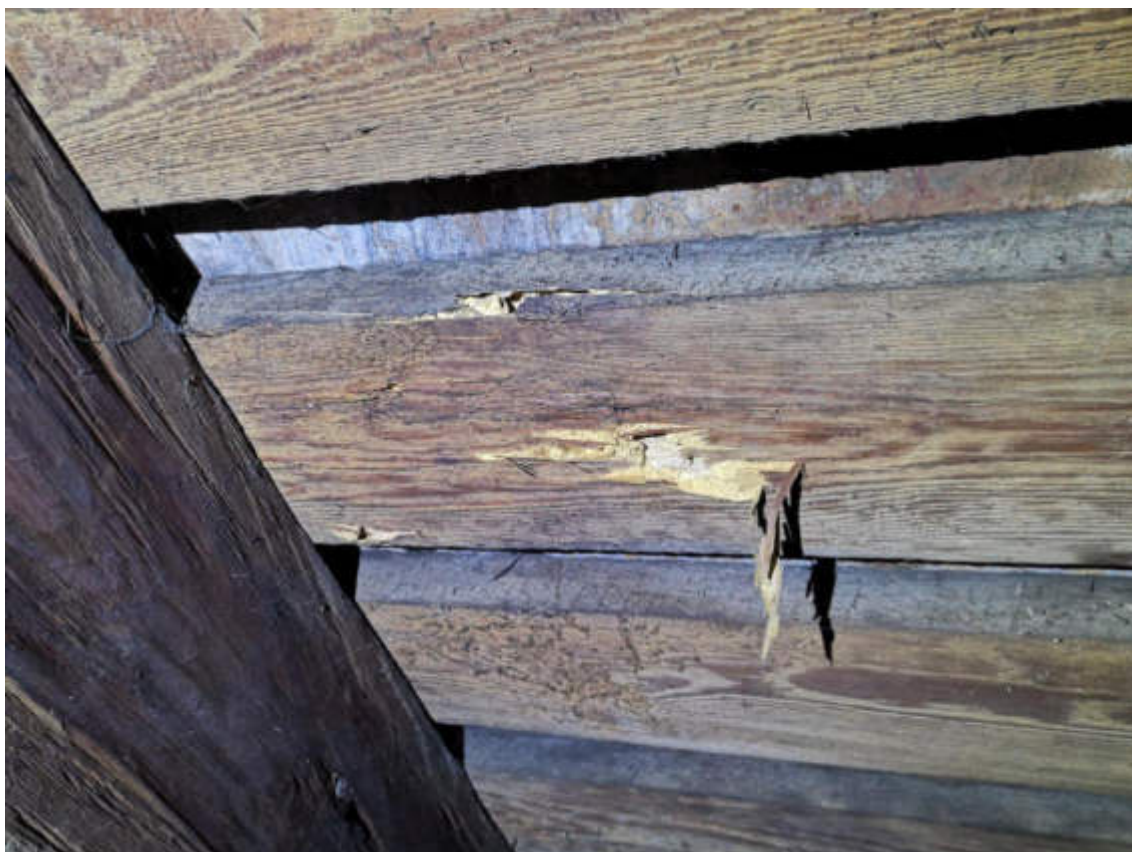
89.fotoattēls. Satrupējis jumta seguma dēļu klājs
