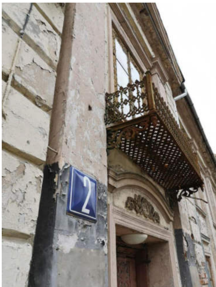
122.fotoattēls. Čuguna balkona konstrukcijas virs ieejas durvīm A korpusā.
