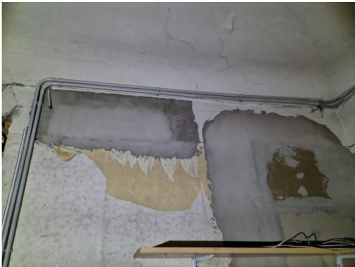
153.fotoattēls. Sekundāri ārsienas apdares labojumi ar cementa javu.
