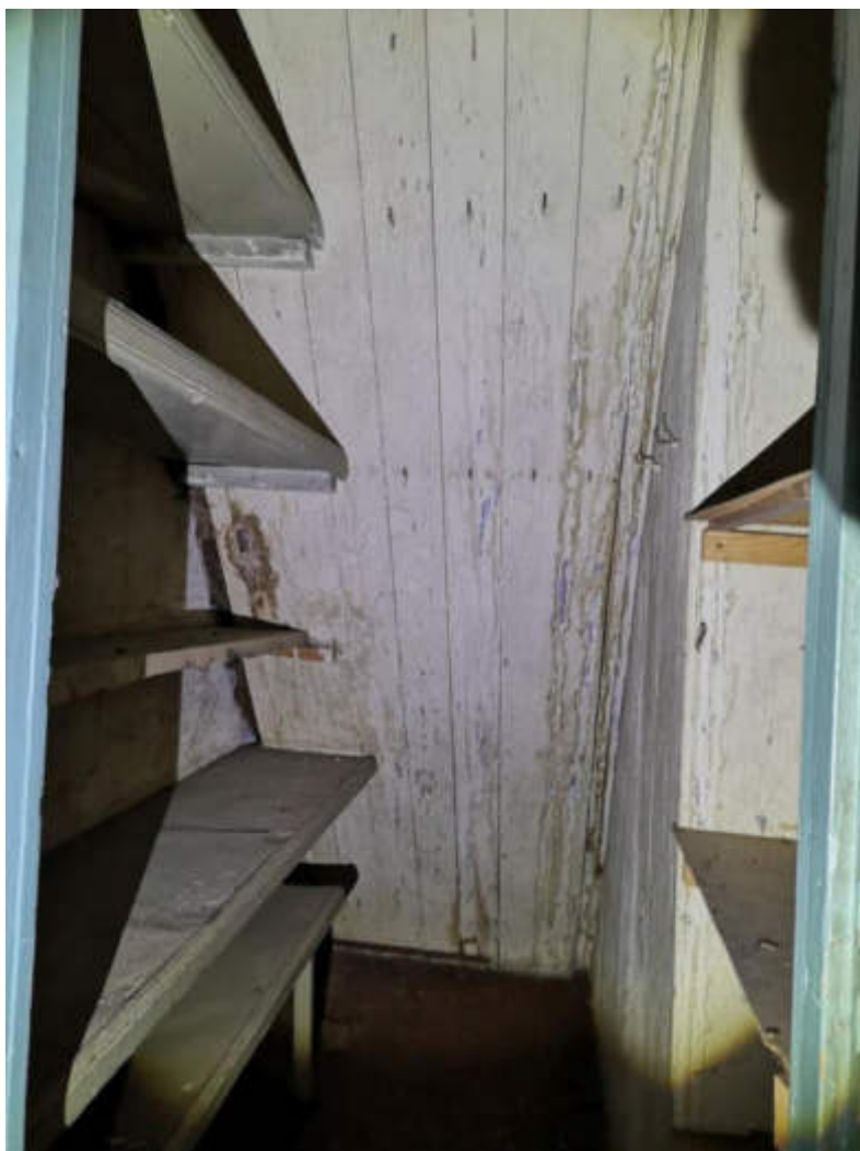
137.fotoattēls. Kāpņu K-4 skats no apakšas.
