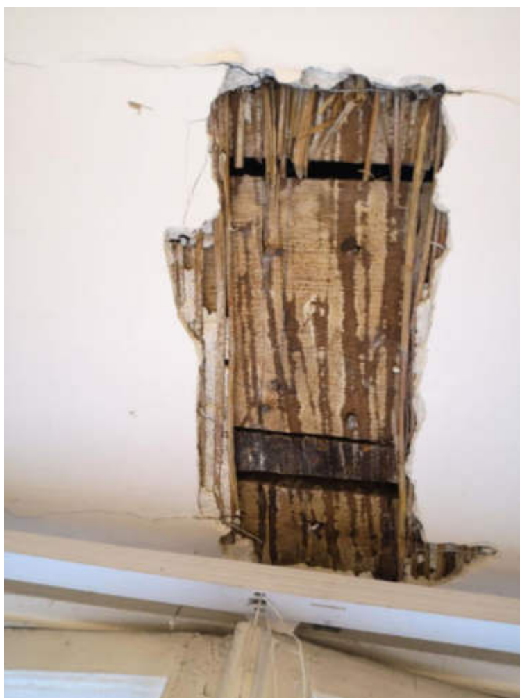
18.fotoattēls. Logailu pārsedzes atsegums [p3]
