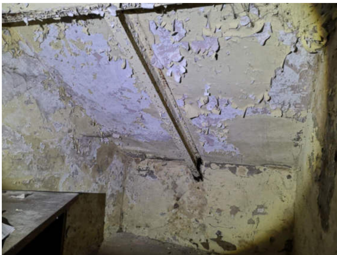
132.fotoattēls. Kāpņu K-3 pakāpienu balstkonstrukcija.
