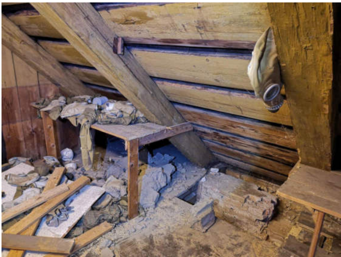
101.fotoattēls. A2 korpusa jumta nesošās konstrukcijas.
