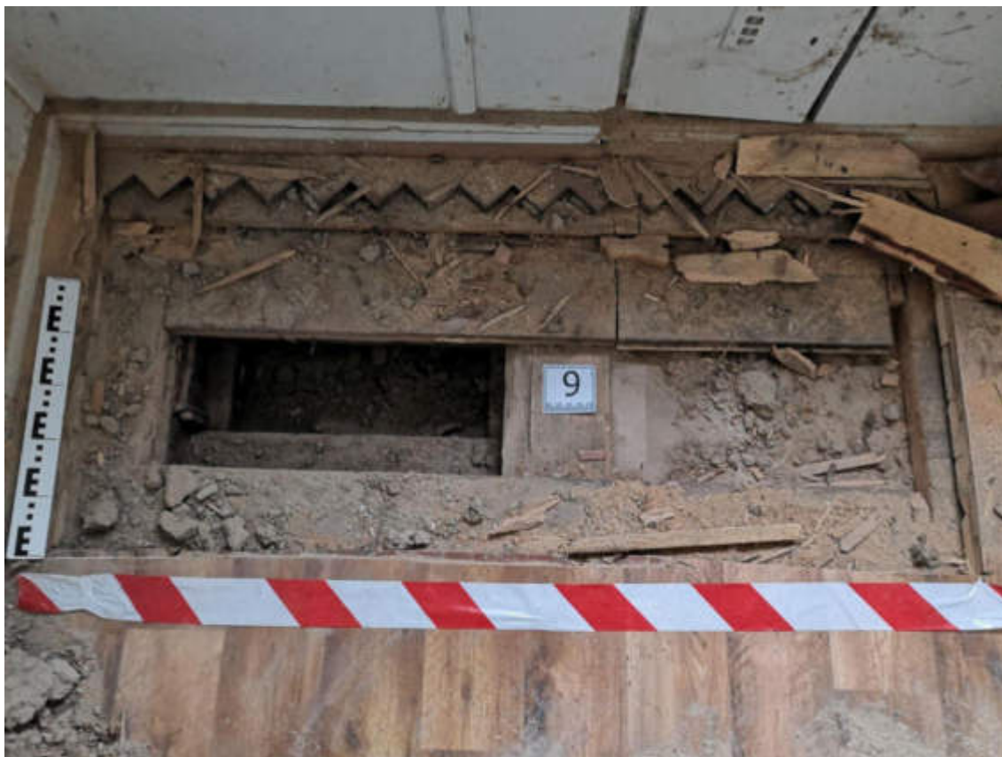
43.fotoattēls. 1.stāva pārseguma konstrukcijas atsegums
