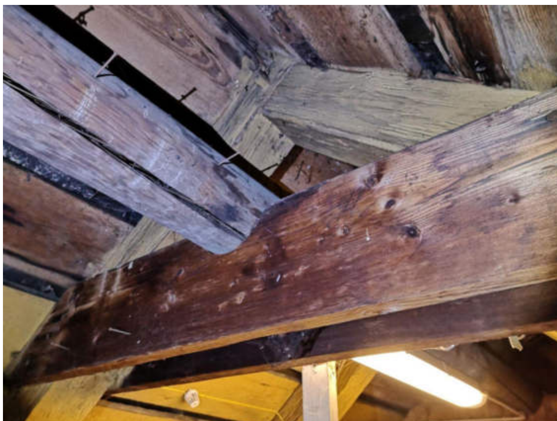
102.fotoattēls. A2 korpusa spāru pāru augšējie saišķi un tajos iedziļinātais apaļkoks, kas kalpojis kā vinča.
