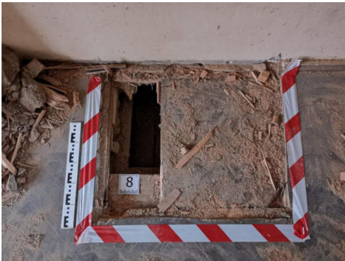
41.fotoattēls. 1.stāva pārseguma konstrukcijas atsegums
