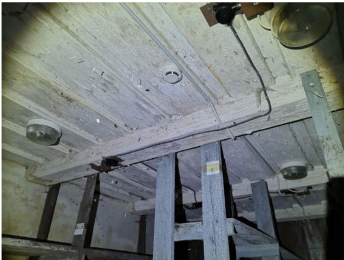
73.fotoattēls. 1.stāva dēļu griesti ar triniša konstrukcijas aizpildījumu.
