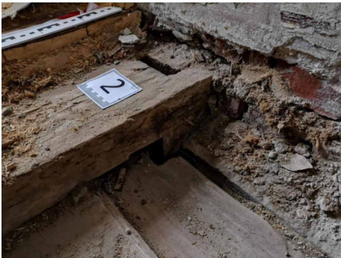
30.fotoattēls. 1.stāva pārseguma konstrukcijas atsegums
