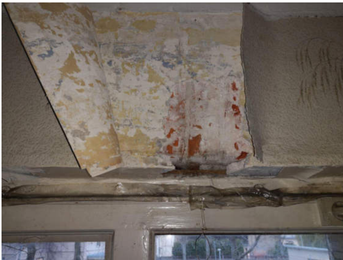
21.fotoattēls. Logailu pārsedzes atsegums [p11]
