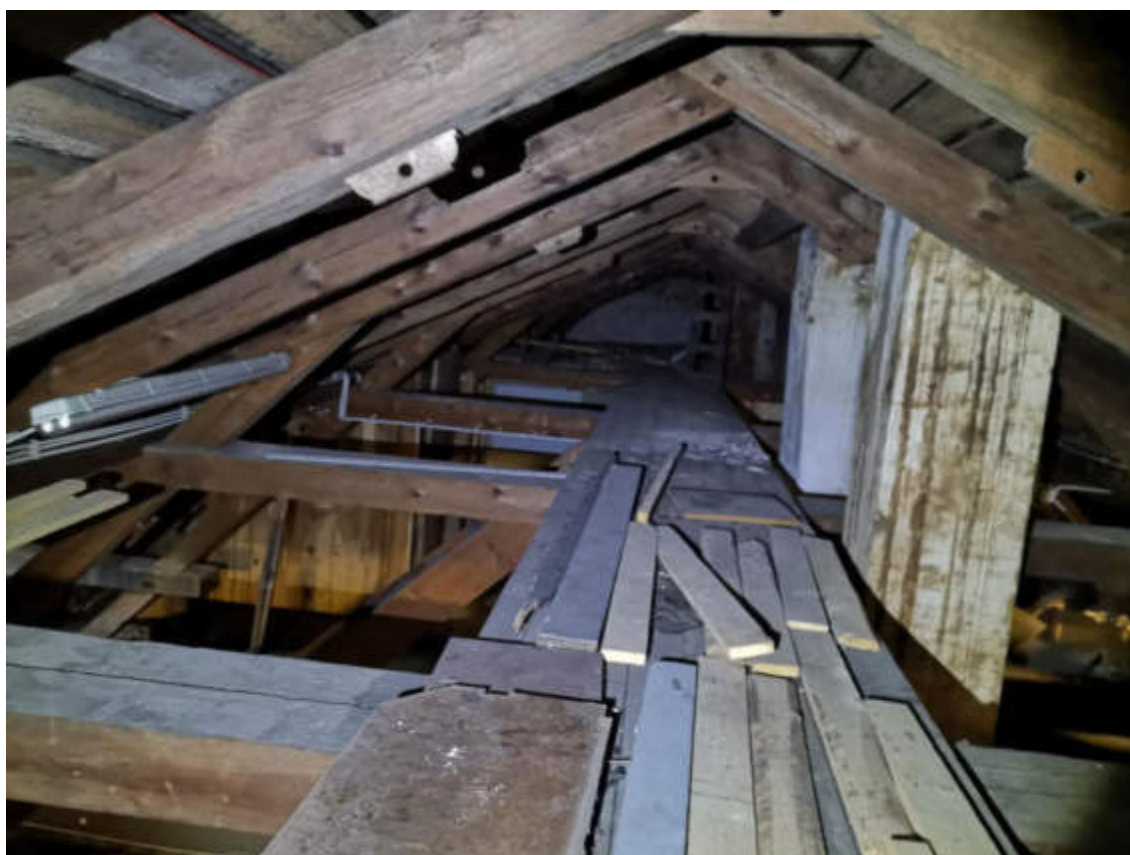
84.fotoattēls. A korpasa bēniņu apkalpes laipas virs augšējiem saišķiem.
