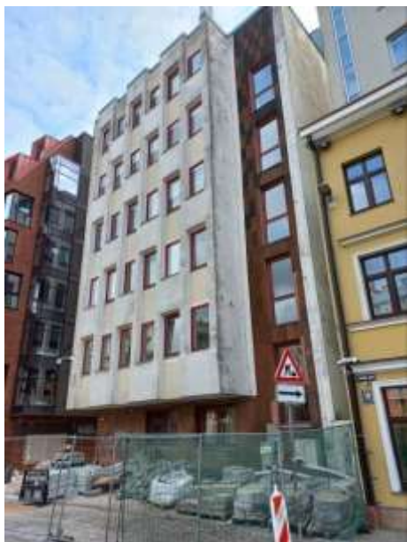
Ēkas fasādes daļa, skats no Kalēju ielas puses
