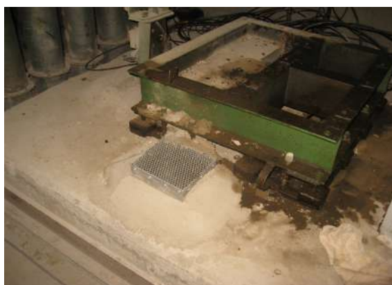
F-16. Lifta šahtas augšas betonēta plātne uz metāla profila. Iekārtas ir mainītas, mainot lifta kabīni.
