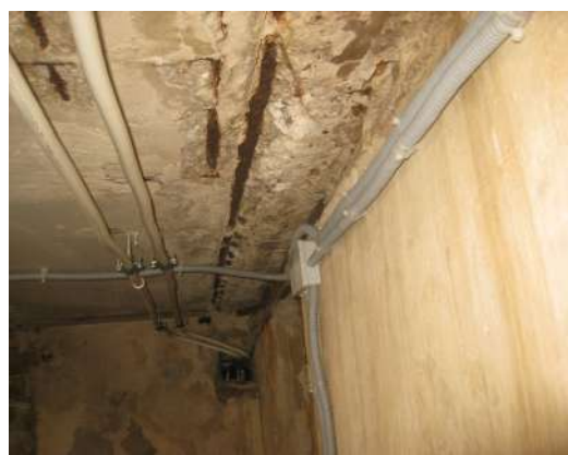
F-8. Pārsegums lifta mašīntelpā jau sākotnēji neprecīzs. Redzama armatūra, vaļīgs šuvju aizpildījums.
