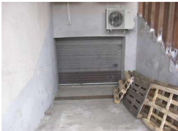
F-13. Panduss, kas nodrošina iespēju iebraukt pagraba stāvā, betonēts ar ūdens novadīšanas tekni apakšas līmenī.
