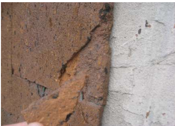
F-19. Apdares plāksnes kļuvušas drupenas, bez tam arī atdalījušās no līmjavas.
