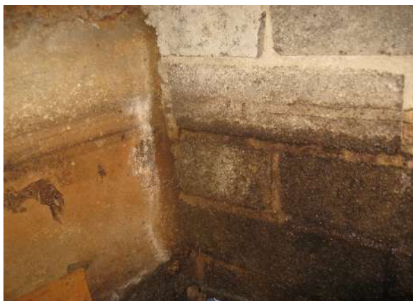
F-4. Betona pamats zem pagraba grīdas padziļinājuma vietā, kur ierīkota gruntsūdens pazemināšanas sistēma. Viena siena no keramzītbetona blokiem.
