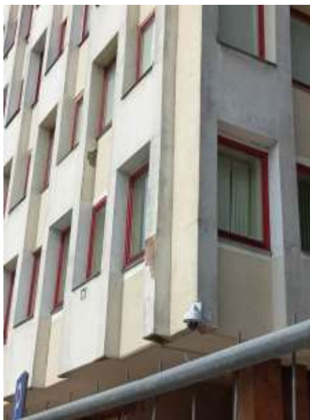
Ēkas fasādes skats
