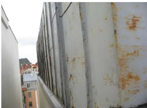
F-17. Izbuvēs uz jumta apšuvumam izmantots skārds ar krāsojumu. Tas stipri nolietojies, ir rūsa, savienojumos trūkst krāsojuma.
