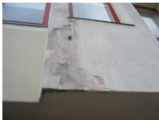
F-19. Apdares plāksnes kļuvušas drupenas, bez tam arī atdalījušās no līmjavas.
