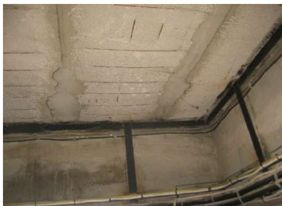
F-8. Pārsegums lifta mašīntelpā jau sākotnēji neprecīzs. Redzama armatūra, vaļīgs šuvju aizpildījums.
