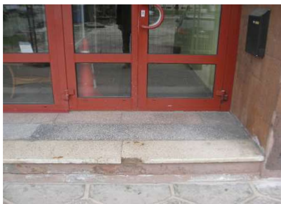
F-11. Galvenās ieejas durvis ar pakāpienu, kura centrā izlūzis plāksnes gabals. Sānu sienas ar masā tonētām kaļķakmens plātnēm.
