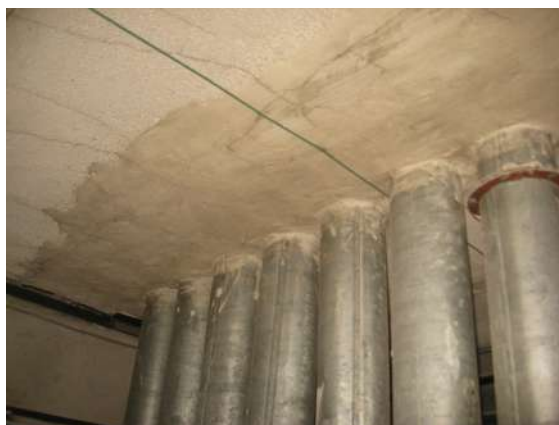
F-15. Skārda ventilācijas kanāli šķērso pārsegumus. To detaļas un pievienojumu vietas apmierinošā stāvoklī.
