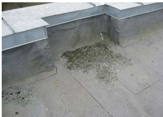
F-10. Jumta klājs un cinkota skārda nosega virs sienām, vietām neliels apaugums.
