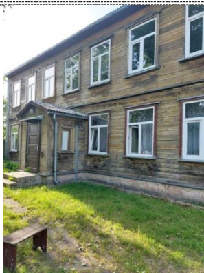
Ēkas fasāde no ielas puses
