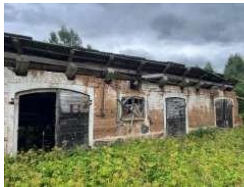
Būve (saimniecības ēka) ar kadastra apzīmējumu 8448 005 0105 003
