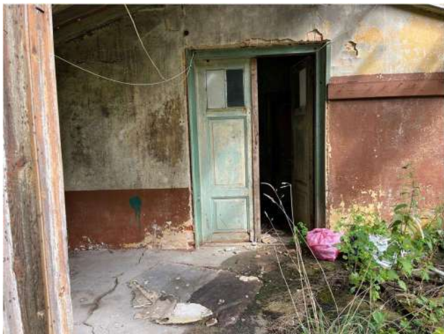
Veranda (telpa Nr. 1)
