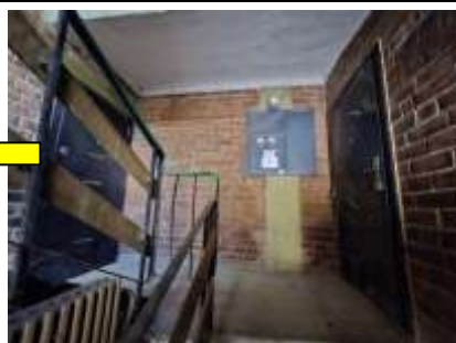
1.stāva kāpņu telpa
