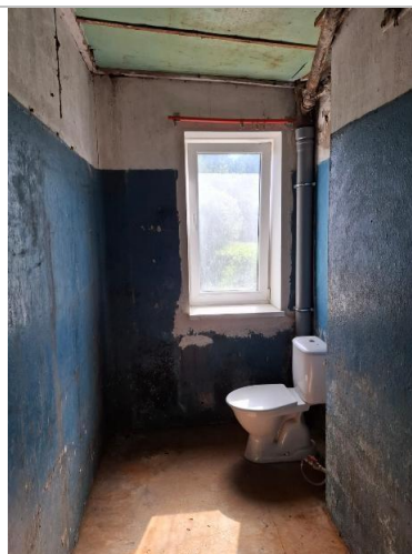
Sanitārā telpa , telpa Nr. 5
