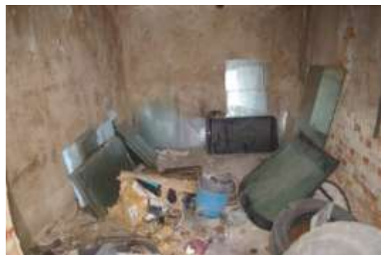
Būve (noliktavas ēka) ar kadastra apzīmējumu 6415 003 0189 002
