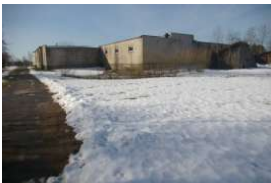
Kopskats uz vērtējamo Objektu no Uguns ielas puses
