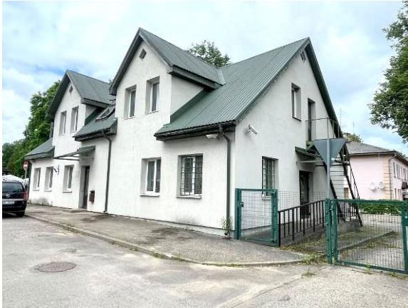
Skats uz vērtējamo ēku no Rīgas ielas puses
