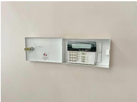
Apsardzes signalizācijas pulsts
