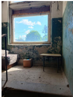
5.attēls. Kāpņu telpa
