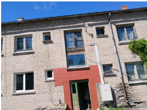
1.attēls. Dzīvojamās mājas fasāde
