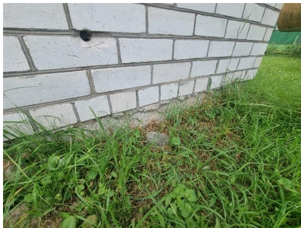
4.1.1. att. Skats uz ēkas pamatiem cokola līmenī
