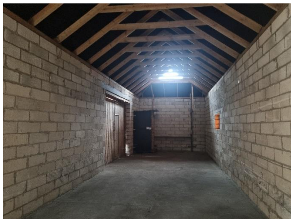
4.2.1. att. Skats uz ēkas nesošām sienām
