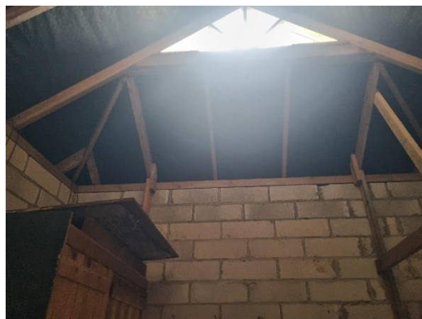
4.8.2. att. Jumta nesošās konstrukcijas
