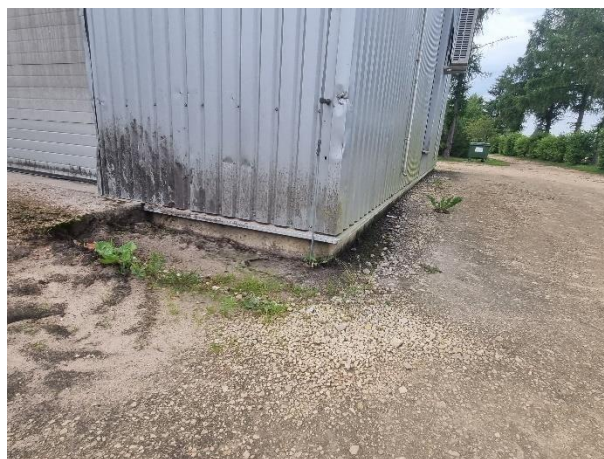
4.1.2. att. Skats uz ēkas pamatiem cokola līmenī (noliktavas daļa)
