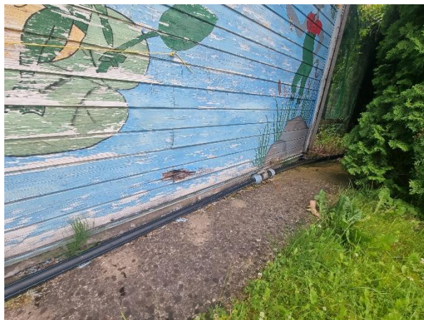
4.19.3. att. Apšuvuma dēļiem radušies trūpes bojājumi, ko iespējams veicināja nehermētisks ūdens caurules savienojums
