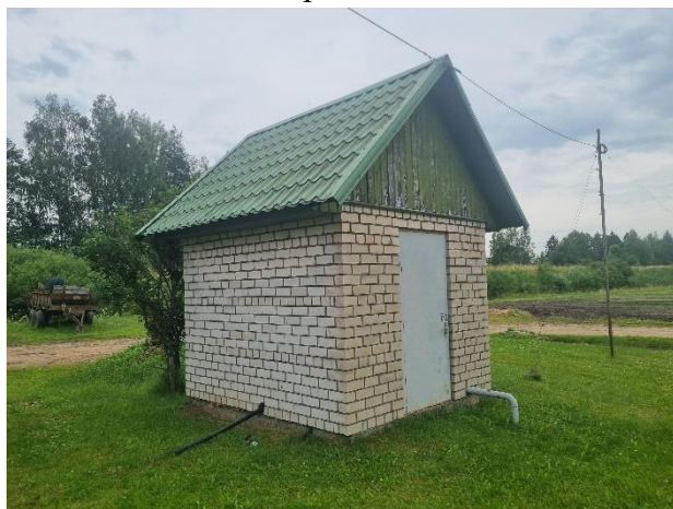
2.2.4.att. Skats uz ēku no ziemeļrietumu puses
