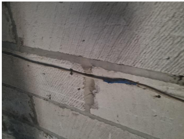
5.9.1. att. Labota kabeļa izolācija
