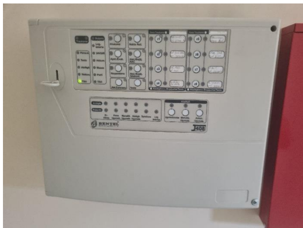
5.3.1. att. Ugunsgrēka atklāšanas un trauksmes signalizācijas sistēmas uztveršanas, kontroles un indikācijas iekārtas
