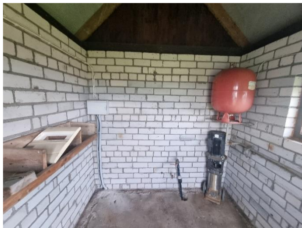
4.2.1. att. Skats uz ēkas nesošām sienām
