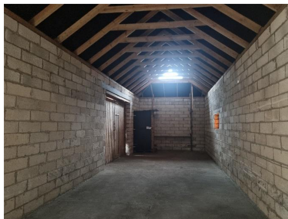
4.12.2. att. Betona grīdas segums
