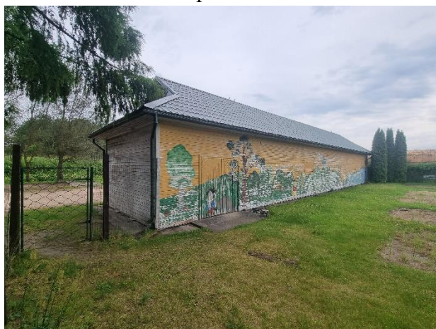
2.2.4.att. Skats uz ēku no ziemeļrietumu puses
