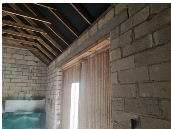
4.2.5. att. Ailu pārsedzes bez būtiskiem bojājumiem
