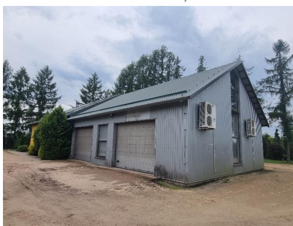
4.8.4. att. Jumta segums virs noliktavas daļas
