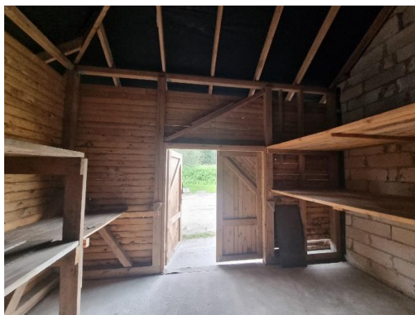
4.12.1. att. Betona grīdas segums
