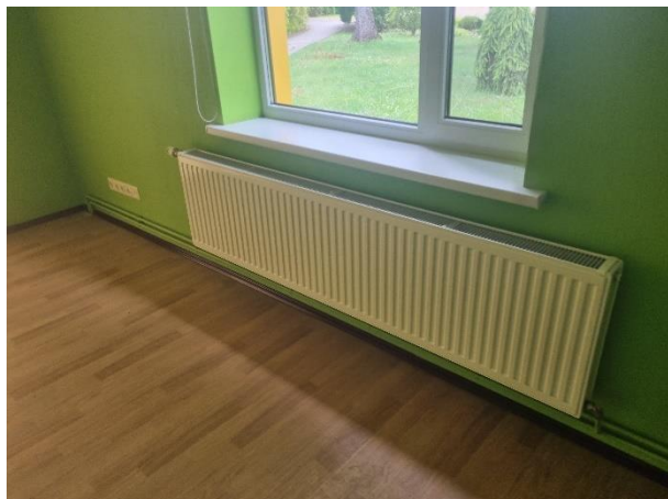
4.2.1. att. Skats uz ēkas nesošā ārsienu
