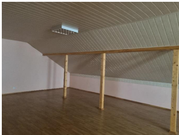
4.8.1. att. Jumta nesošās konstrukcijas (jumta krēsls un statņi) divstāvu apbūves daļā
