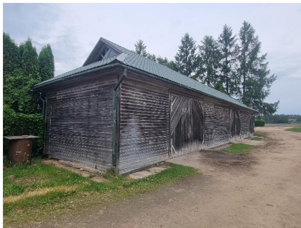
2.2.2.att. Skats uz ēku no dienvidaustrumu puses
