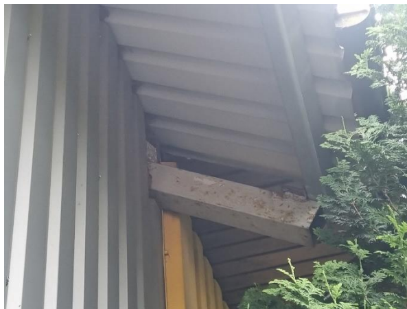
4.8.2. att. Jumta nesošās konstrukcijas virs noliktavas daļas
