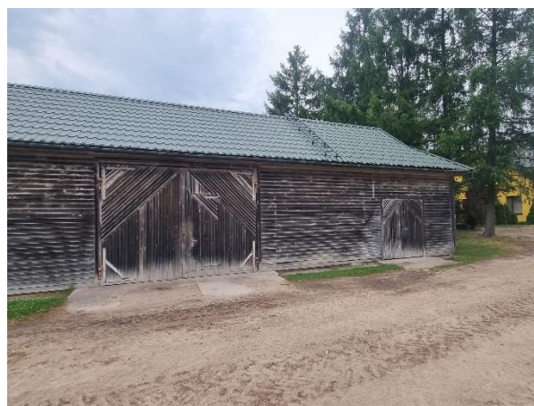
4.13.2. att. Koka konstrukcijas veramie vārti
