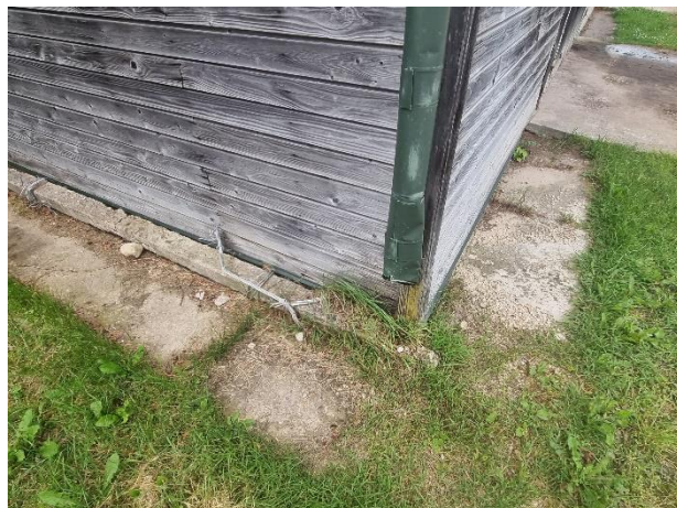
4.1.2. att. Skats uz ēkas pamatiem cokola līmenī
