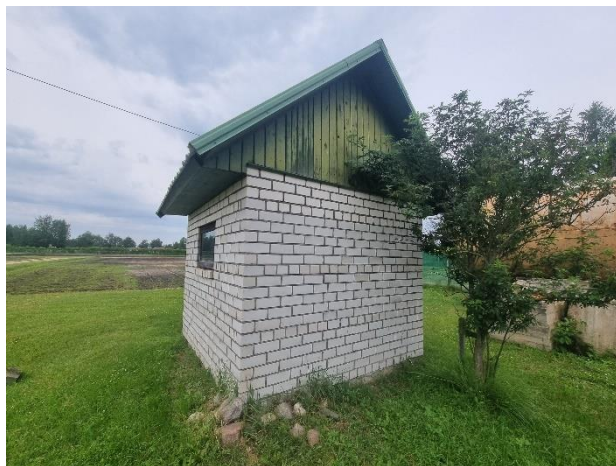
2.2.2.att. Skats uz ēku no dienvidaustrumu puses
