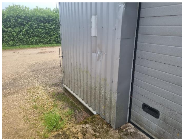
4.19.1. att. Mitruma iedarbības rezultātā radušies apdares bojājumi
