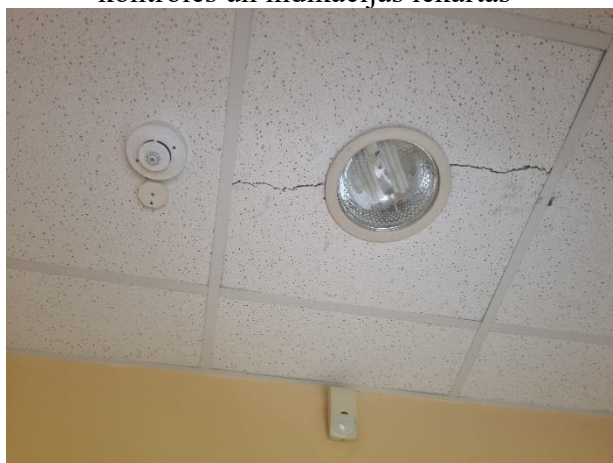
5.3.7. att. Automātiskās ugunsgrēka atklāšanas un trauksmes signalizācijas sistēmas dūmu detektors un virsgriestu dūmu detektora indikators
