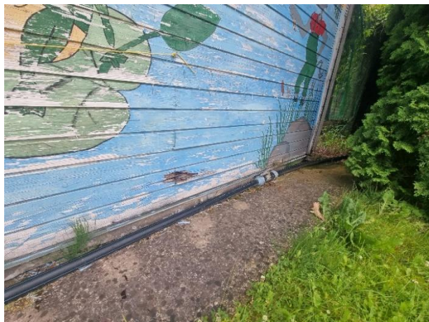
4.1.1. att. Skats uz ēkas pamatiem cokola līmenī
