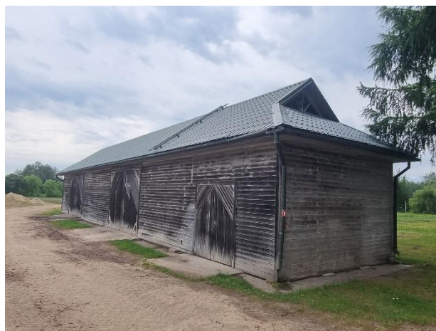
2.2.5.att. Skats uz ēku no ziemeļaustrumu puses
