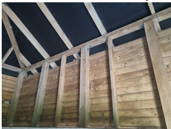
4.8.3. att. Jumta nesošās konstrukcijas šķūņa daļā
