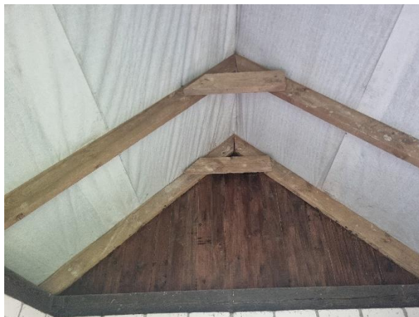
4.8.1. att. Jumta nesošās konstrukcijas
