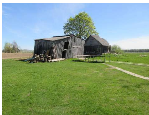
zemes gabals- piemājas zeme ar neregistrēto būvi
