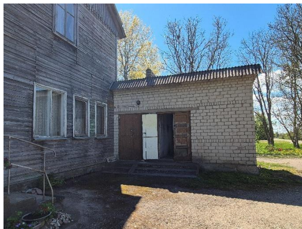
Ūdens ņemšanas vieta ēkas 1.stāvā
