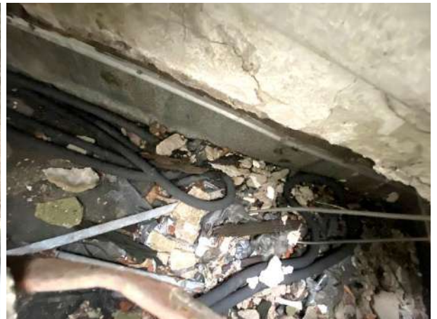
8. un 9. att. Uz plakanā/lēzenā ruļļmateriālu seguma jumta redzami apmetuma fragmenti, u.c. gruži, kas kavē ūdens novadīšanu
