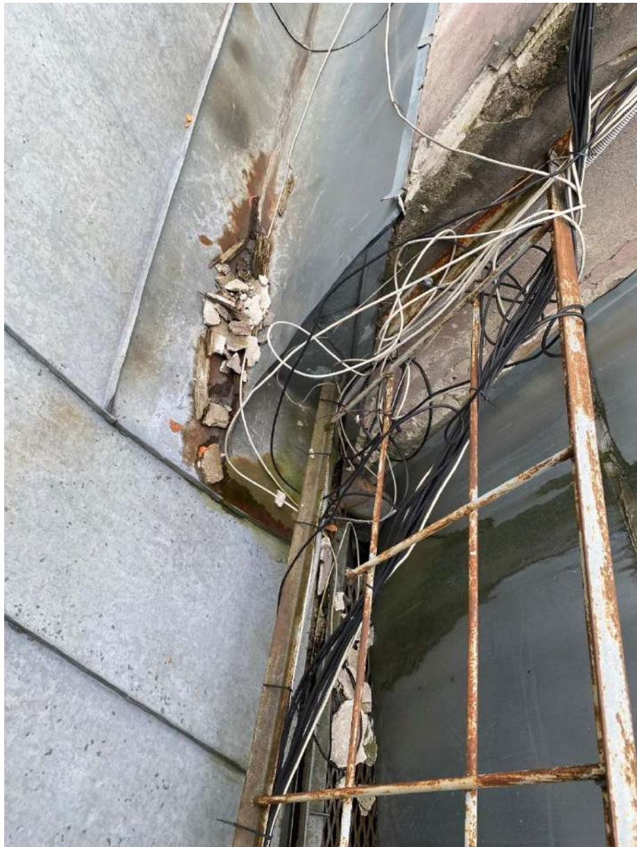
16. att. Uz jumta sakrituši apmetuma fragmenti, tie nosprostojusi lietus ūdens tekni
