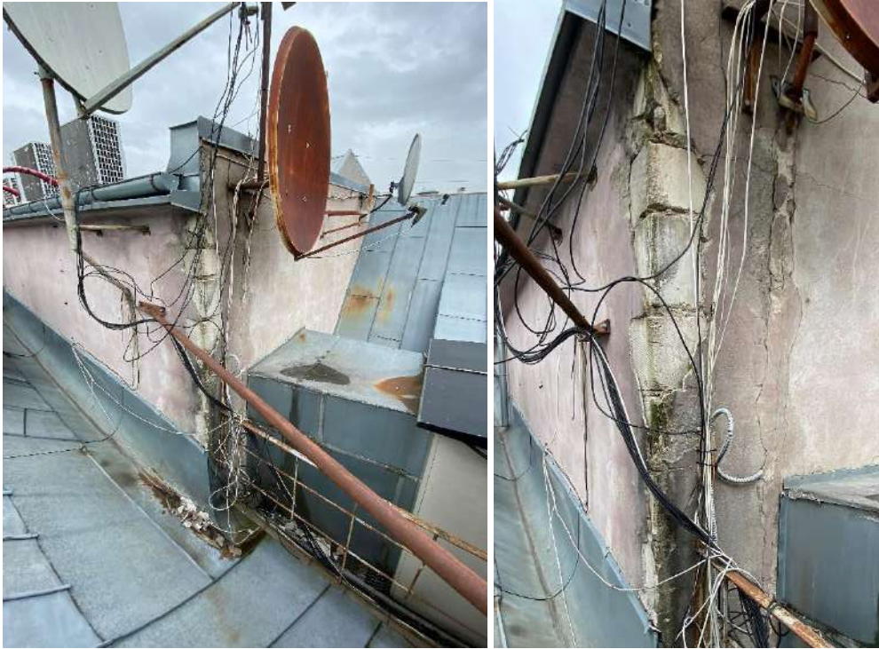
14. un 15. att. Apmetuma fragmenti atdalījušies no virsjumta apjoma fasāžu stūra
