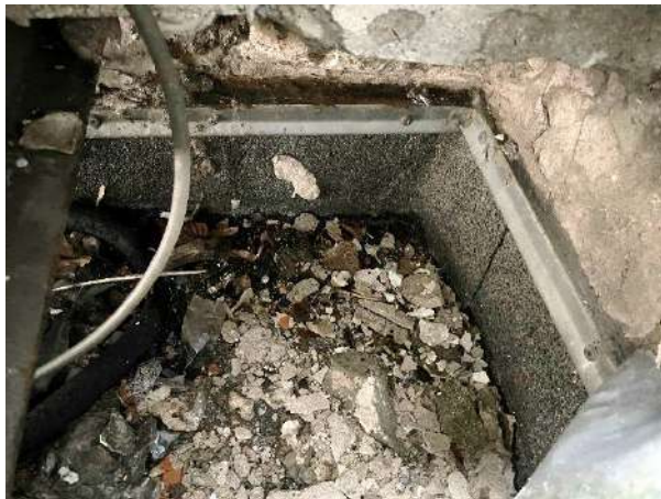
8. un 9. att. Uz plakanā/lēzenā ruļļmateriālu seguma jumta redzami apmetuma fragmenti, u.c. gruži, kas kavē ūdens novadīšanu
