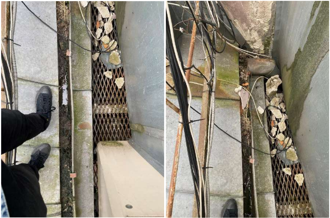
10. un 11. att. Nosprostota lietus ūdens tekne, tā vairs nefunkcionē. Teknē, uz jumta un režģa sakrituši apmetuma fragmenti
