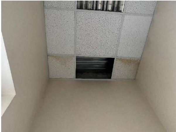
6. un 7. att. Griestu apdares bojājumi. Virs piekārtajiem griestiem redzamas profilētās jumta loksnes. Uz sienām redzami notecējumi
