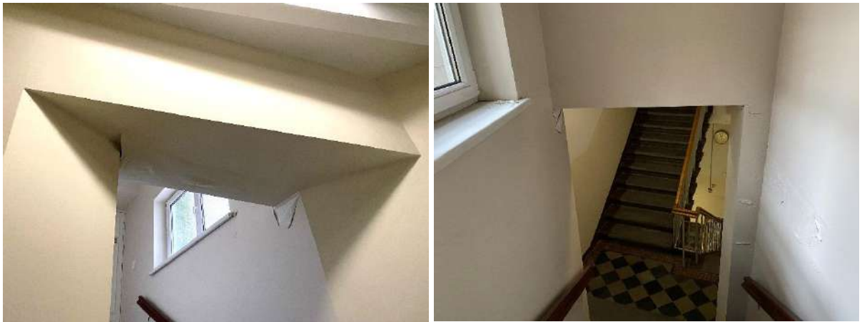
1. un 2. att. Bojāta sienu un ailes apdare
