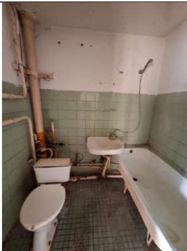
Sanitārā telpa, telpa Nr. 3
