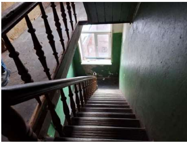
Kāpņu telpa pie vērtējamā dzīvokļa
