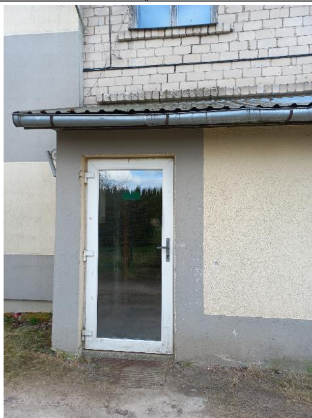
Kāpņu telpas ārdurvis
