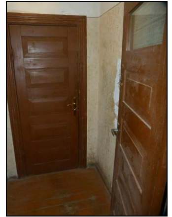
Tualete kāpņu telpā
