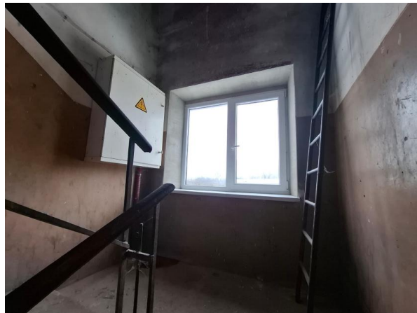
Kāpņu telpa pie vērtējamā objekta
